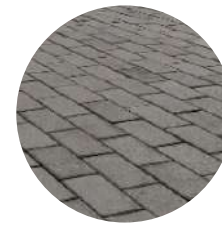
Adoquines en concreto
