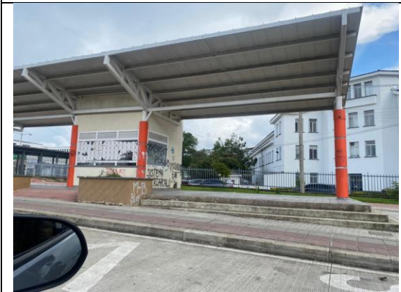
Construcción de paraderos con espacio público (P.E.P)
