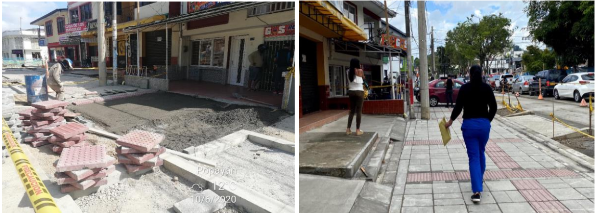
Figura 37 construcción de espacio público facilitando el acceso a la vivienda con respecto al nivel de vía
