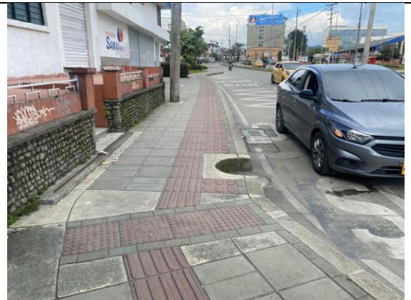
Construcción de infraestructura para transporte público
