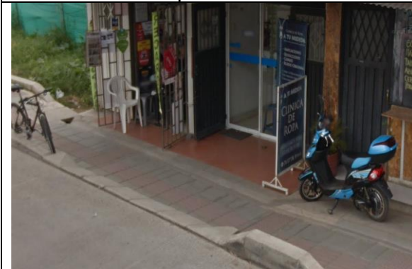
Construcción de cañuelas para drenar aguas lluvias del espacio público
