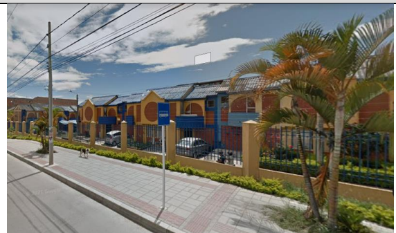
Construcción infraestructura para espacio público
