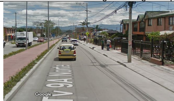
Construcción de accesos vehiculares
