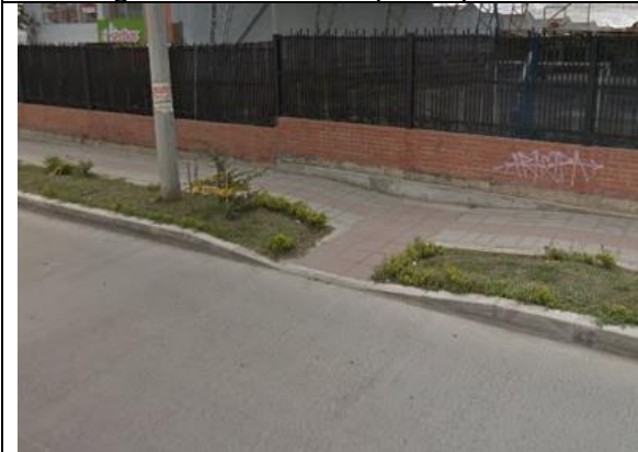
Construcción de paso a nivel
