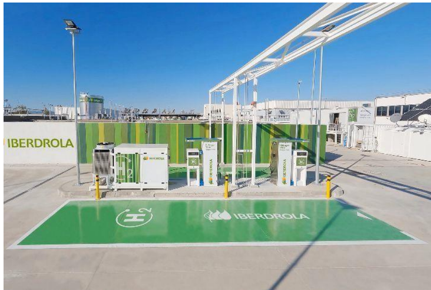
Figura 20. Hidrogenera de Iberdrola [29].
