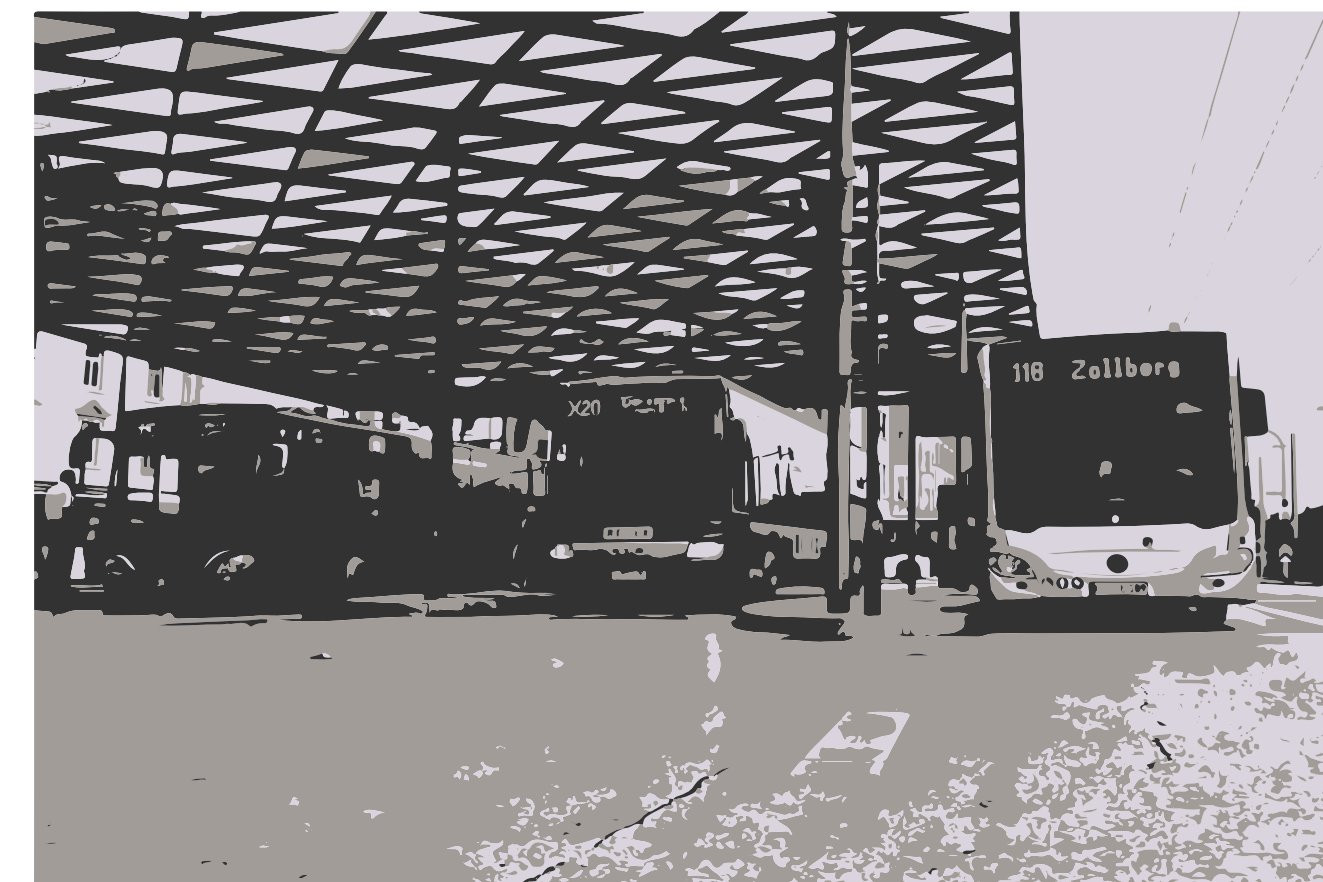
ZOB Esslingen Referente Internacional Cubierta y estructura modular
