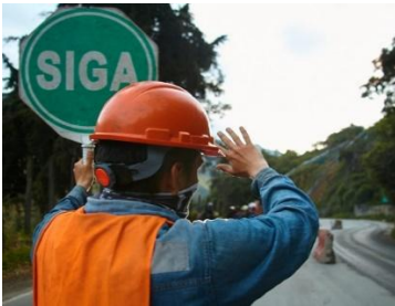
Ilustración 9. Mantenimiento vial (La república, 2023e)
