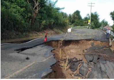
Ilustración 6. Perdida de bancada (Saldarriaga, 2022)
