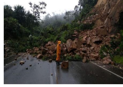
Ilustración 8. Deslizamiento de tierra (Caracol Radio, 2020)
