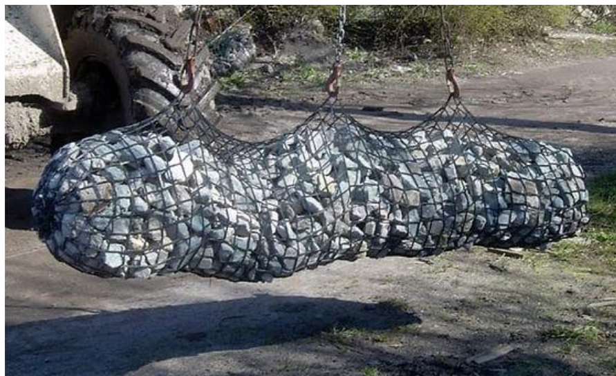
Figura 22. Sacos de gaviones, como alternativa de solución a la socavación.
