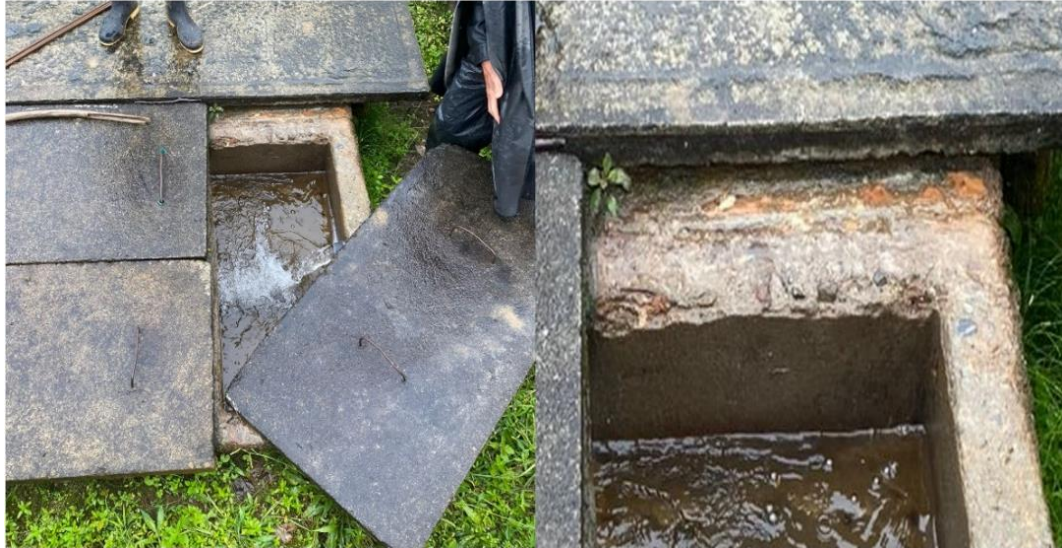
Figura 8. Desarenador, acercamiento en estructura
