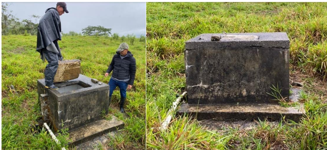
Figura 6. Cámara de quiebre, vista frontal y lateral
