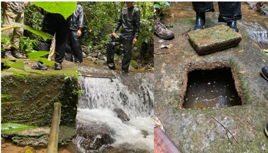
Figura 9. Cámara de recolección, vista superior y lateral.
