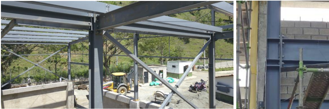
Figura 7. Estructura parcialmente instalada
