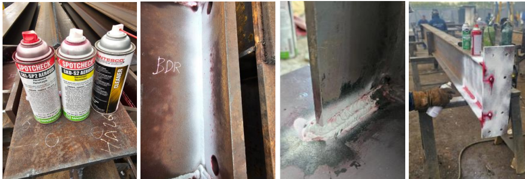
Figura 5. Pruebas de tinta en taller para estructura metálica en taller, Proyecto “CONSTRUCCIÓN BODEGA SAN JOSÉ”
