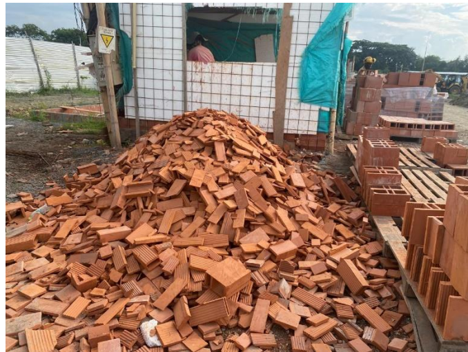
Figura 11. Acopio de la zona de corte de mampostería
