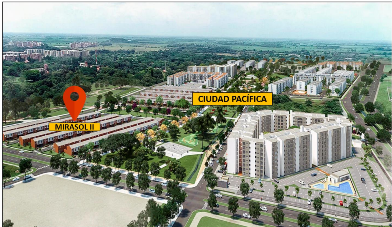
Figura 11. Mega proyecto Ciudad Pacífica (tomado de: https://www.constructorabolivar.com/proyectos-vivienda/cali/ciudad-pacific ).
