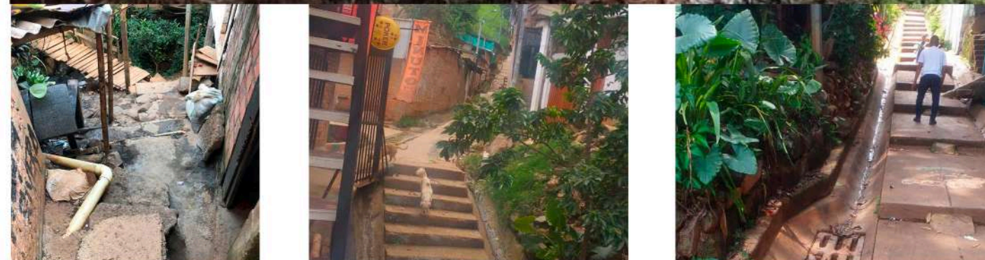
FIGURA 36 : Fotografías conexiones zona de ladera.
