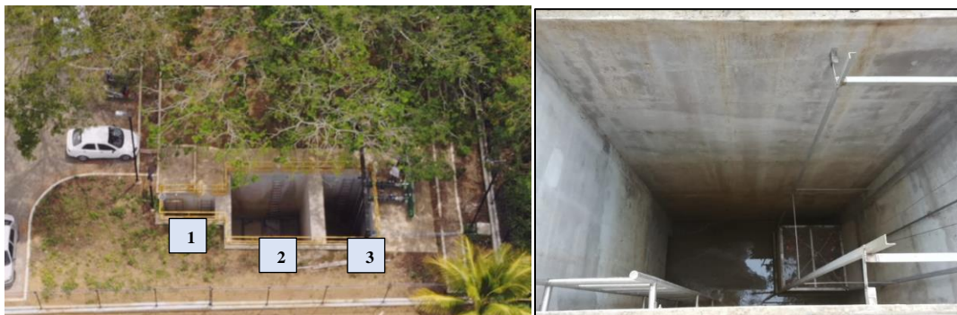
Figura 15. Canal de desbaste (der.); Trampa de grasas (Izq.)
