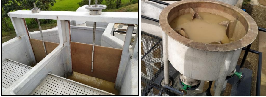
Figura 12. Canal de aproximación hacia unidades de rejillas (izq.); Cadica (der.)
