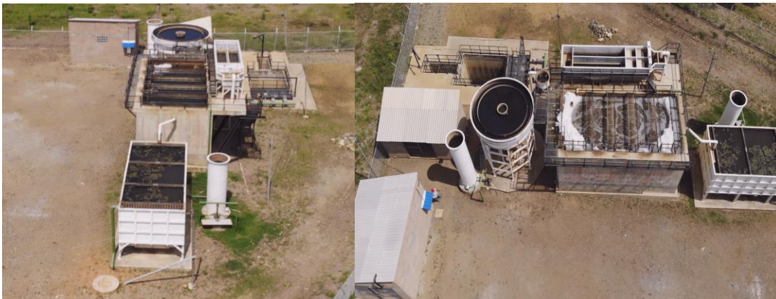
Figura 10. Vista aérea de las unidades de tratamiento
