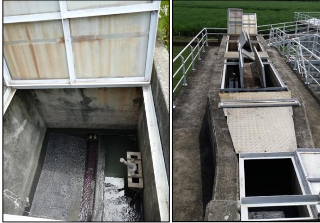
Figura 32. Estructura de entrada a la planta (izq.); desarenador (der.)
