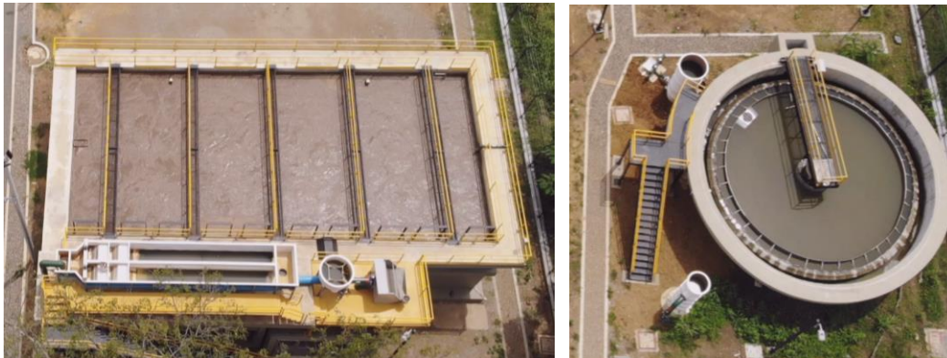
Figura 17. Estructuras de tratamiento secundario: Tanque de aireación (izq.) y Sedimentador secundario (der.)
