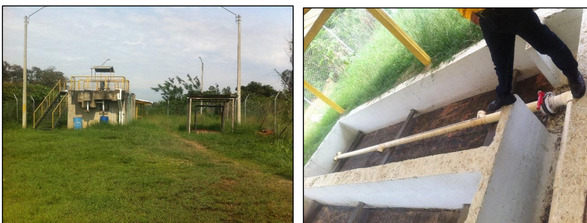
Figura 26. Tanque de Aireación (izq) y Lechos de secado (der) Fuente: Propia
