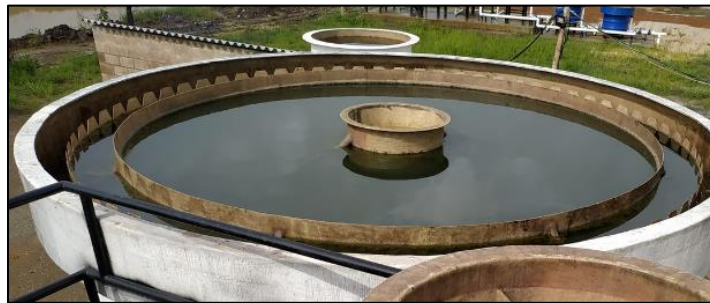
Figura 13. Sedimentador primario
