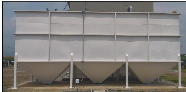
Figura 21. Sedimentador secundario
