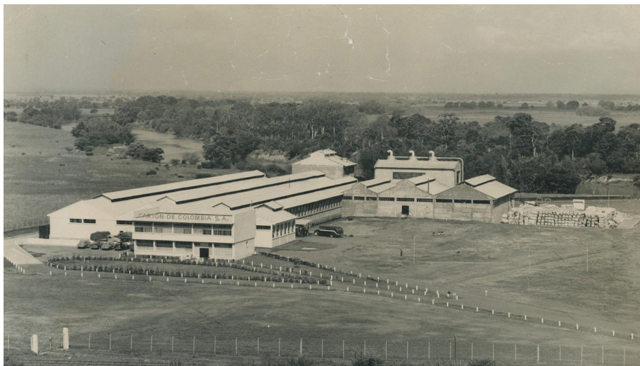
Foto 1. Panorámica de la planta de Cartón de Colombia en Puerto Isaacs. 1950.
