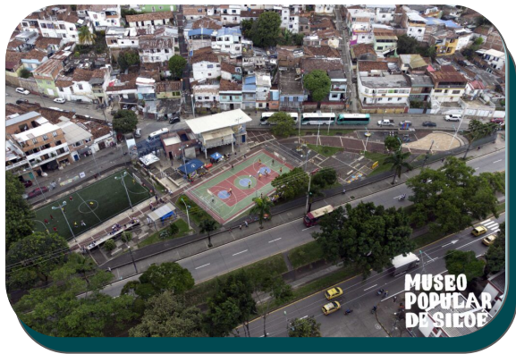
Remodelación de parque
