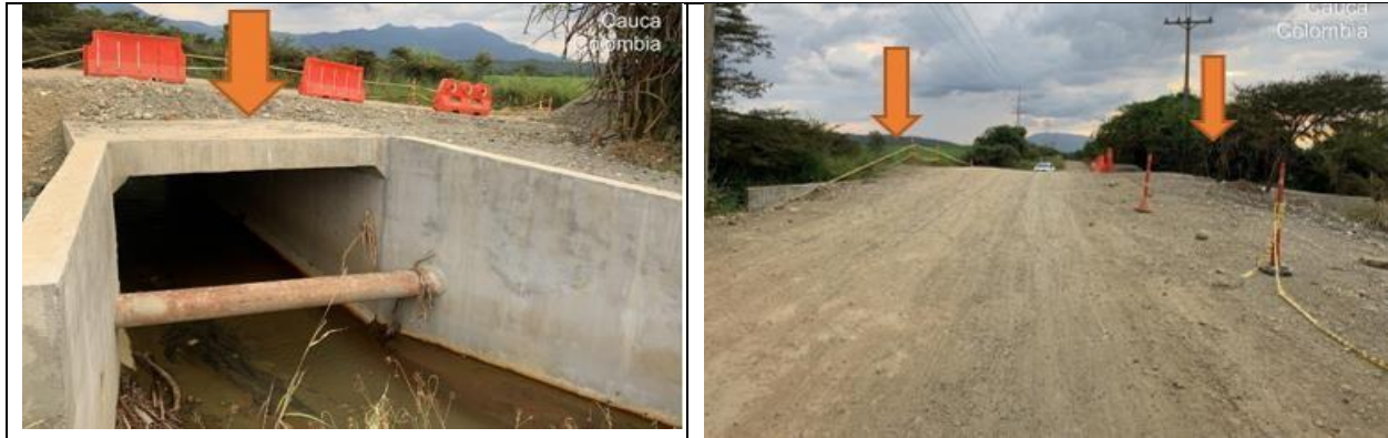
Imágenes No. 14 Imágenes No 15. Box Culvert K0 + 992 fase terminada Caloto-Cauca
