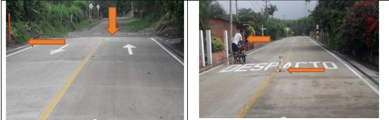
Imágenes No. 20 Imágenes No 21 K3+108 AL K3 +312 Pavimento Vehicular la Quebrada
