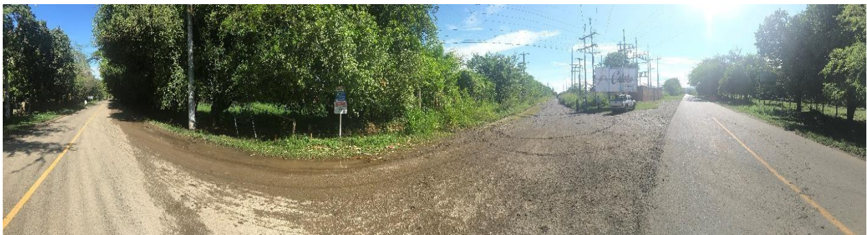
Ilustración 2. Carretera Santander de Quilichao- Caloto intersección Crucero Japio-Crucero del Guali
