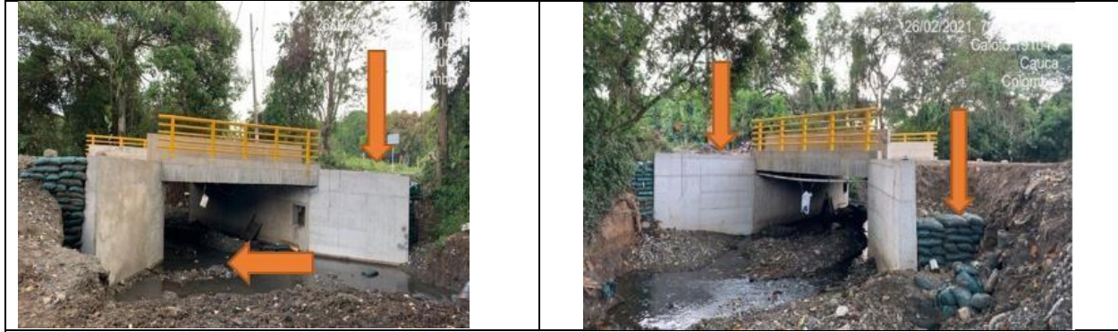
Imágenes No. 24 Imágenes No. 25 Construcción del Box Culvert Guali K4+ 446 Caloto- Cauca.
