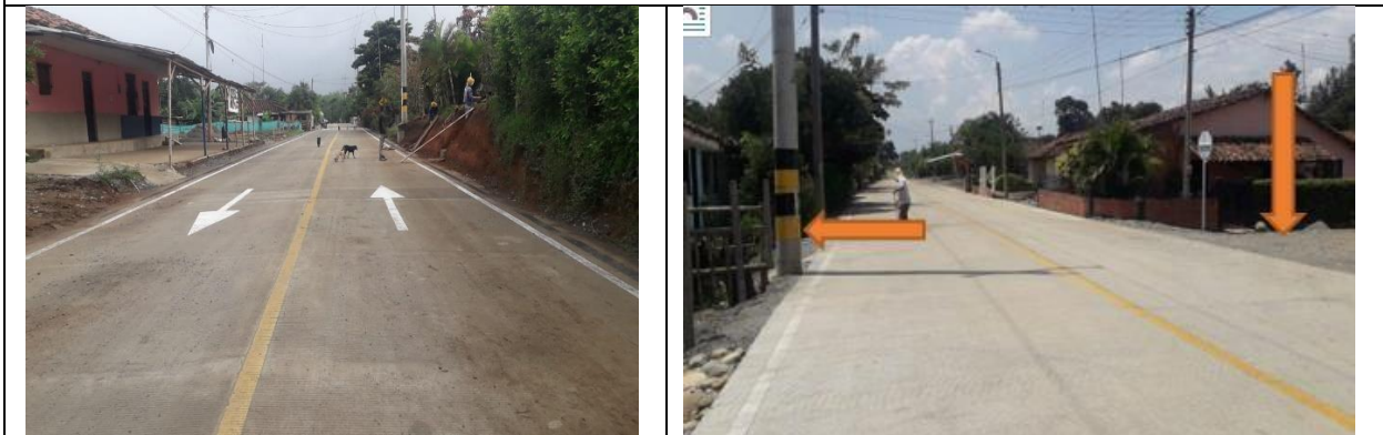
Imágenes No. 22 Imágenes No. 23 K3+108 AL K3 +312 pavimento vehicular la Quebrada
