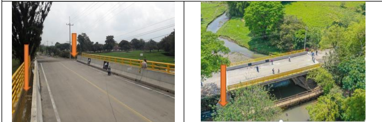
Imágenes No. 16 Imágenes No. 17 K3+535 puente la Quebrada Caloto Cauca,
