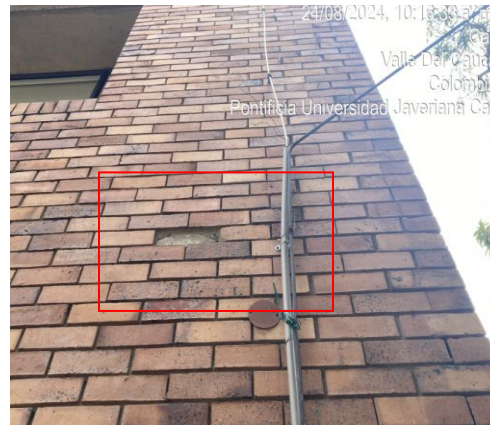
Figura 34. Fachada posterior: a) Zona con presencia de humedades fachada posterior piso 3 b) zona con presencia de desapego piso 2 esquina fachada posterior
