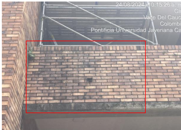
Figura 34. Fachada posterior: a) Zona con presencia de humedades fachada posterior piso 3 b) zona con presencia de desapego piso 2 esquina fachada posterior
