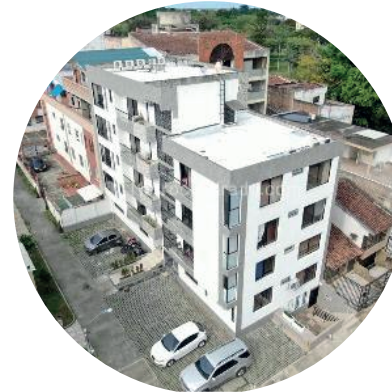
Las fachadas hacia el oeste dejan pasar la radiación solar hacia dentro del espacio
