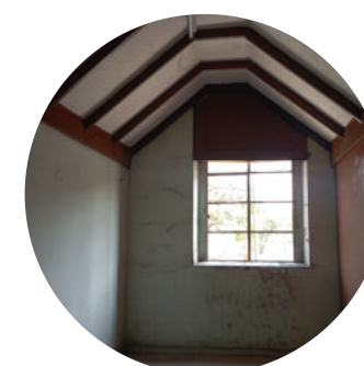
Reconfiguración del espacio del 2do piso (Derribo)
