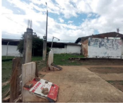
Infraestructura en malas condiciones
