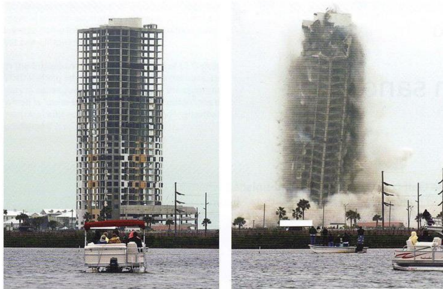
Figura 8. Demolición de torre Ocean Tower en el año 2008.
