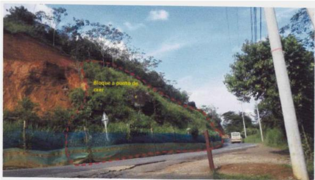
Figura 24. Depósitos coluviales reactivados identificados durante la exploración. Tomado de: Volumen geotécnico Consorcio Vial vía Pance.
