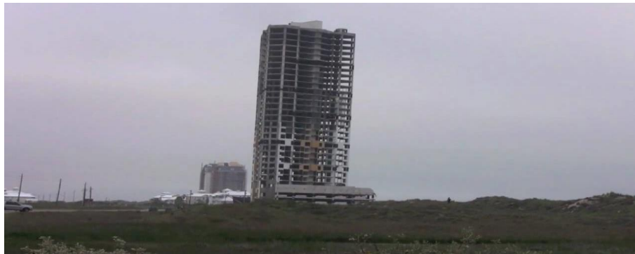
Figura 7. Asentamiento diferencial presentado en estructura de torre Ocean Tower.
