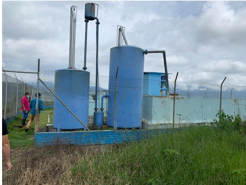
Figura 17. Vista del tanque de almacenamiento del acueducto.
