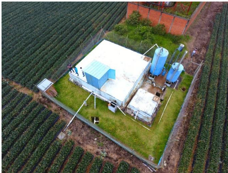
Figura 4. Detalle del tanque de almacenamiento del acueducto Acuapaltres, toma aérea
