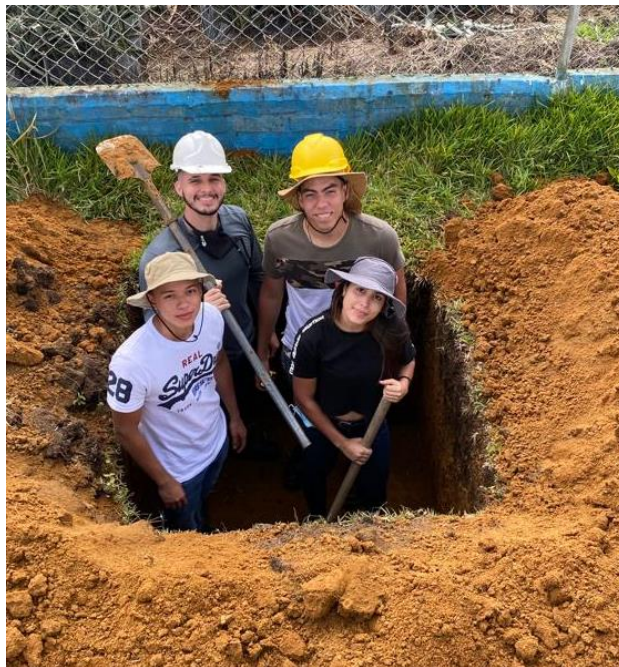
Figura 30. Excavación del apique.
