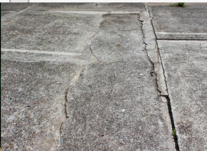
Cancha Desniveles y grietas por toda la cancha. Restauraron rellenando con mas concreto.
