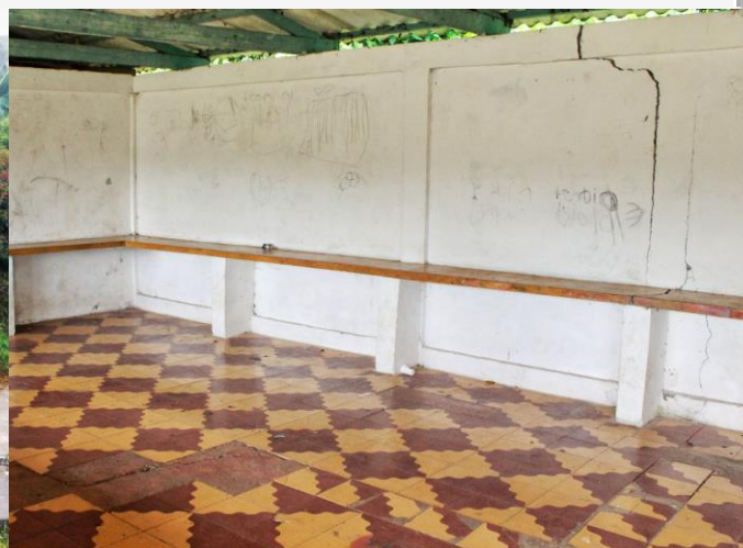
Caseta comunal Una grieta continúa desde las paredes hasta el suelo.
