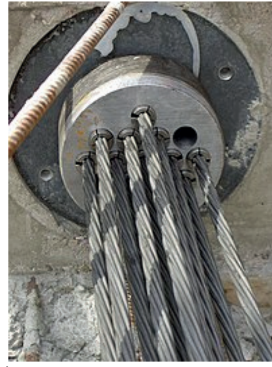
Unión de torones para el pretensado del concreto
