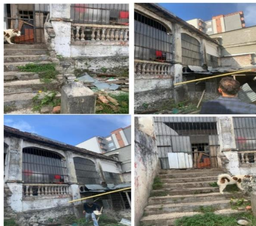
Ilustración 26. Estado actual patio posterior del inmueble
