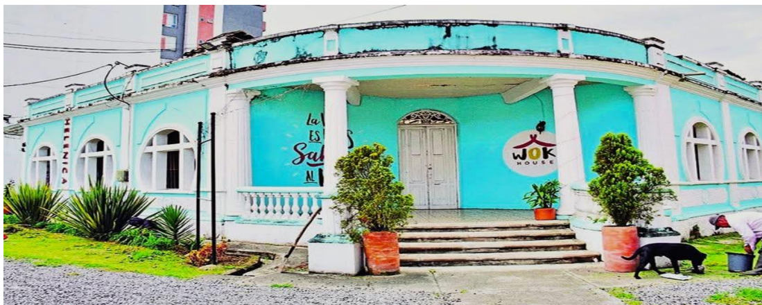
Ilustración 3. Fachada de la vivienda
