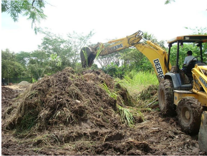
Figura 100: Descapote de terreno con máquina
