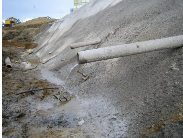
Figura 11: Vista típica de drenes horizontales en taludes.
