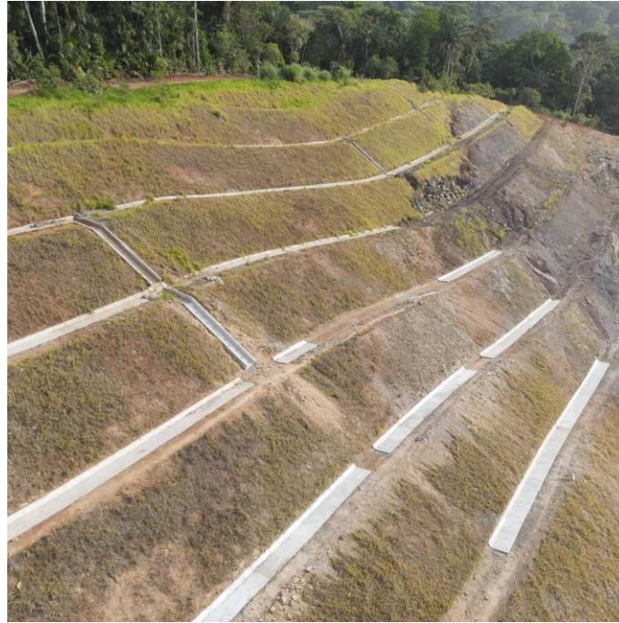
Figura 8: Distribución de cunetas en talud
