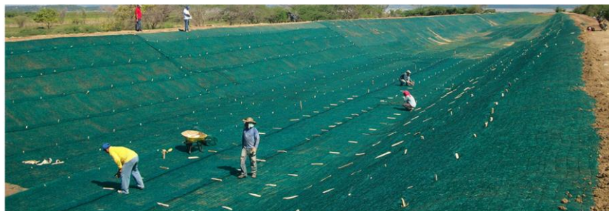
Figura 53: Manto permanente no tejido (TRM500), con anclajes de talud.
