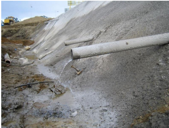
Figura 102: Drenes horizontales instalados
