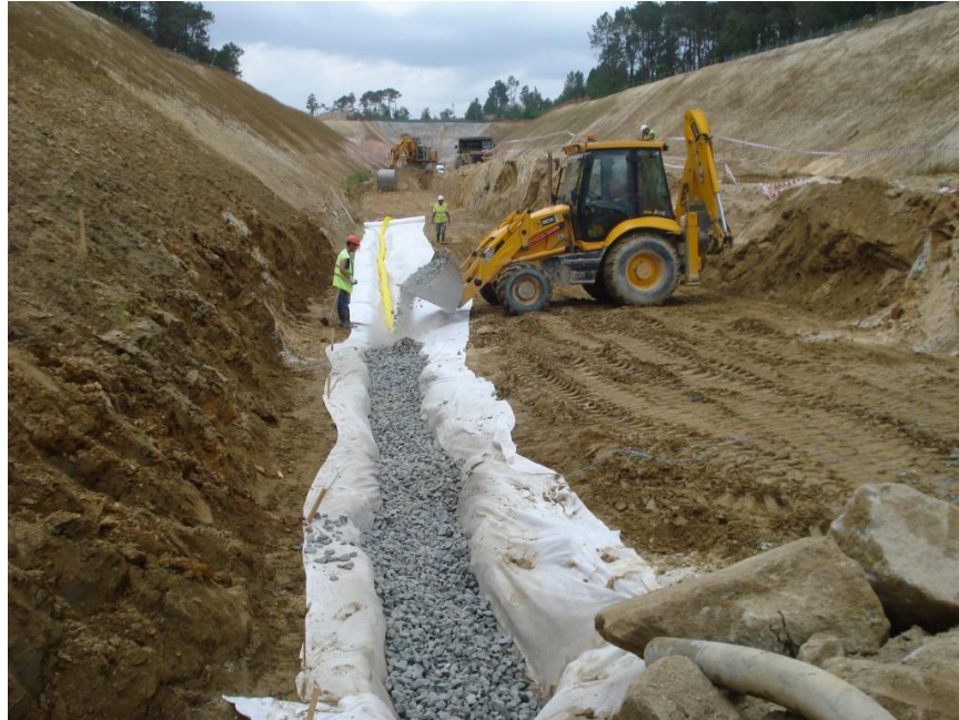
Figura 103: Relleno con grava para trinchera drenante
