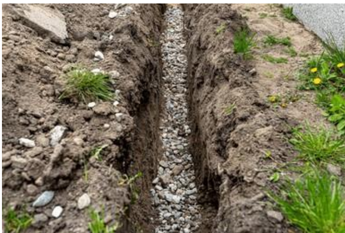
Figura 9: Vista típica de trinchera drenante.
