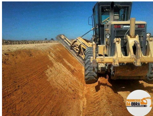
Figura 104; perfilado de talud con motoniveladora
