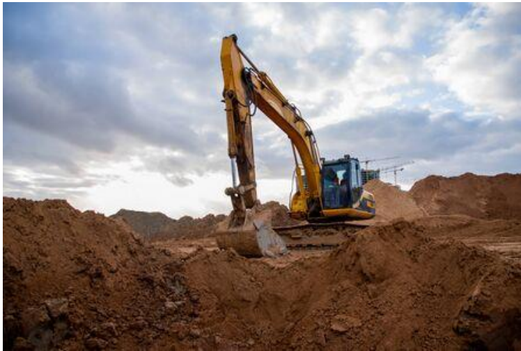
Figura 101: Proceso de excavación con maquinaria
