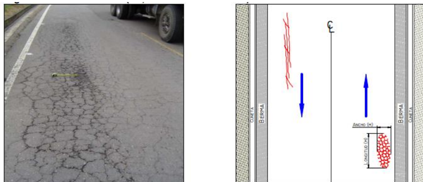
Figura 4. Piel de cocodrilo (PC, Unidad de medida: \text{m}^2 ) [17].
