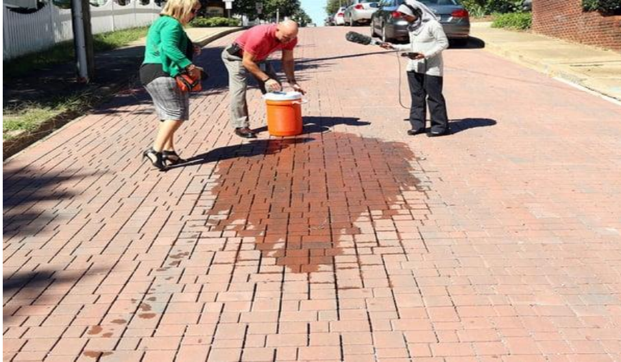
Figura 2 Pavimento de permeable de adoquín implementado por el Departamento de Gestión de Cuencas Hidrográficas de Atlanta (structuralia blog, 2015).
