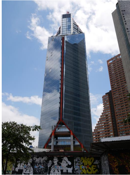
Figura 7 Ejemplo de construcciones desarrolladas con estructuras metálicas de TECMO.
