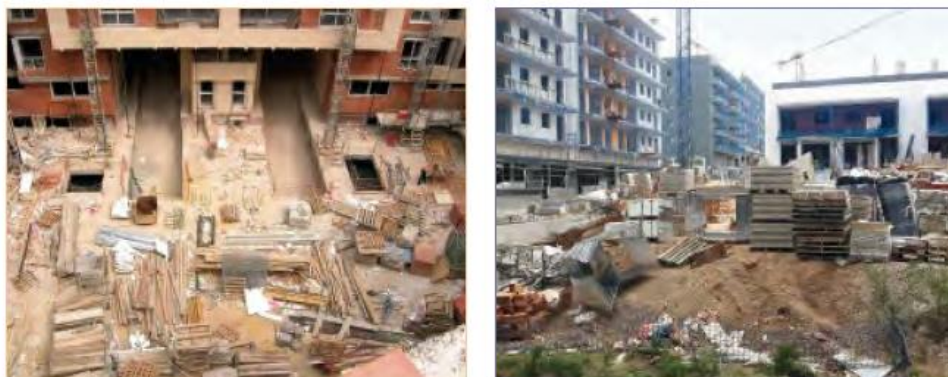
Figura 19 - Obra Edificio de Viviendas Año 2006 y Obra Edificio de Viviendas Año 2018:
