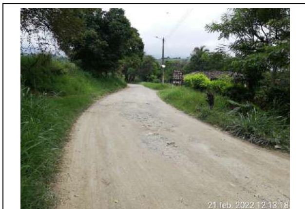
Preliminares de Obra
