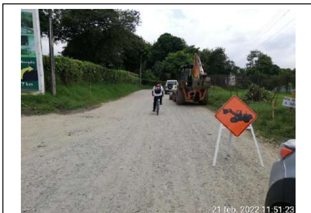
Llegada de Maquinaria a la Obra
