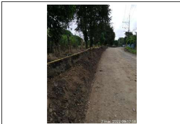
Excavación Lateral para Subdrenajes de Vía
