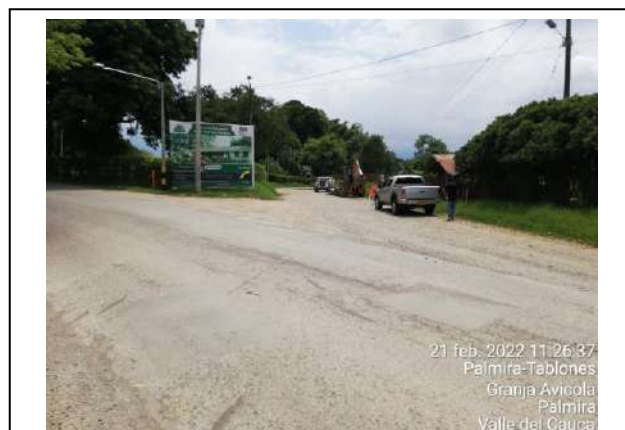
Llegada de Maquinaria a la Obra
