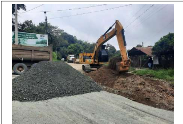
Cajeo de Vía - K0+000
