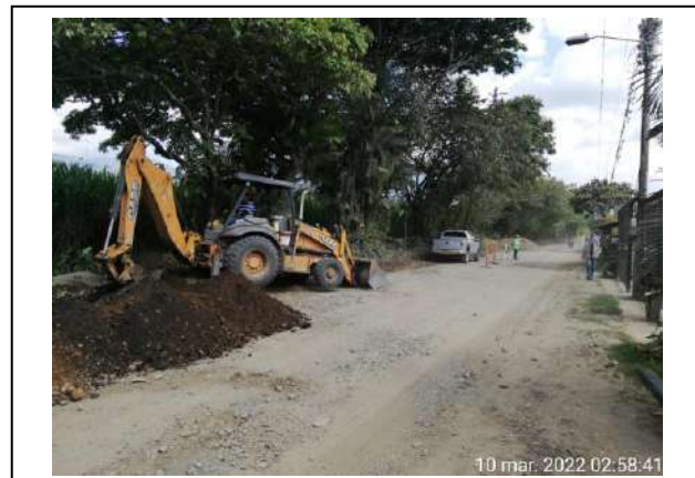
Excavación Lateral para Subdrenajes de Vía
