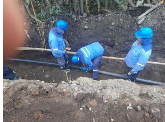
Reposición Redes Acueducto por Interferencia
