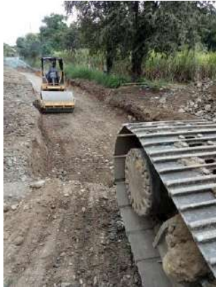
Reposición de Afirmado en Zona de Hundimiento
