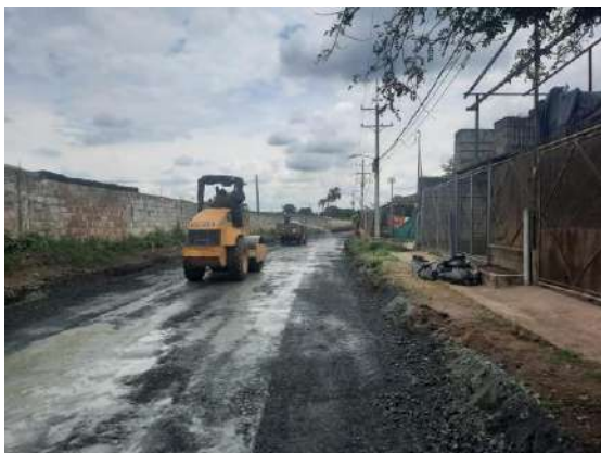
Compactación de Base Granular
