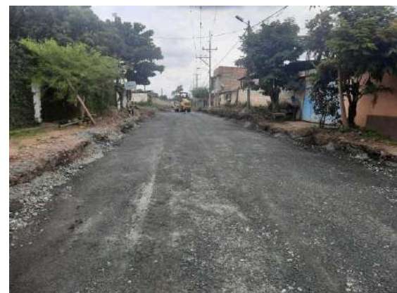
Compactación de Base Granular
