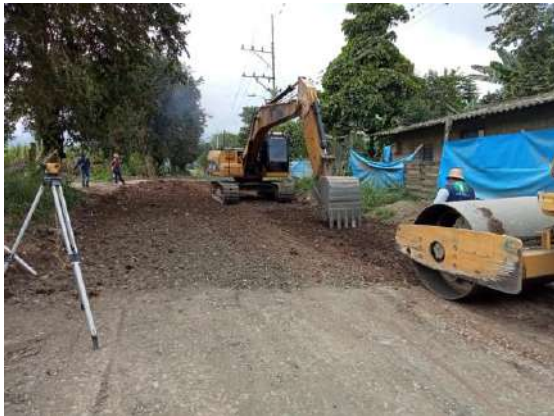
Escarificación de Subrasante
