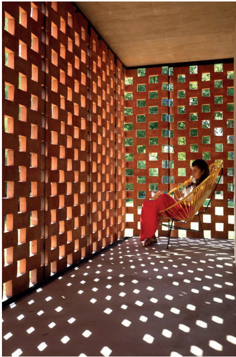
M7 : MURO CALADO
