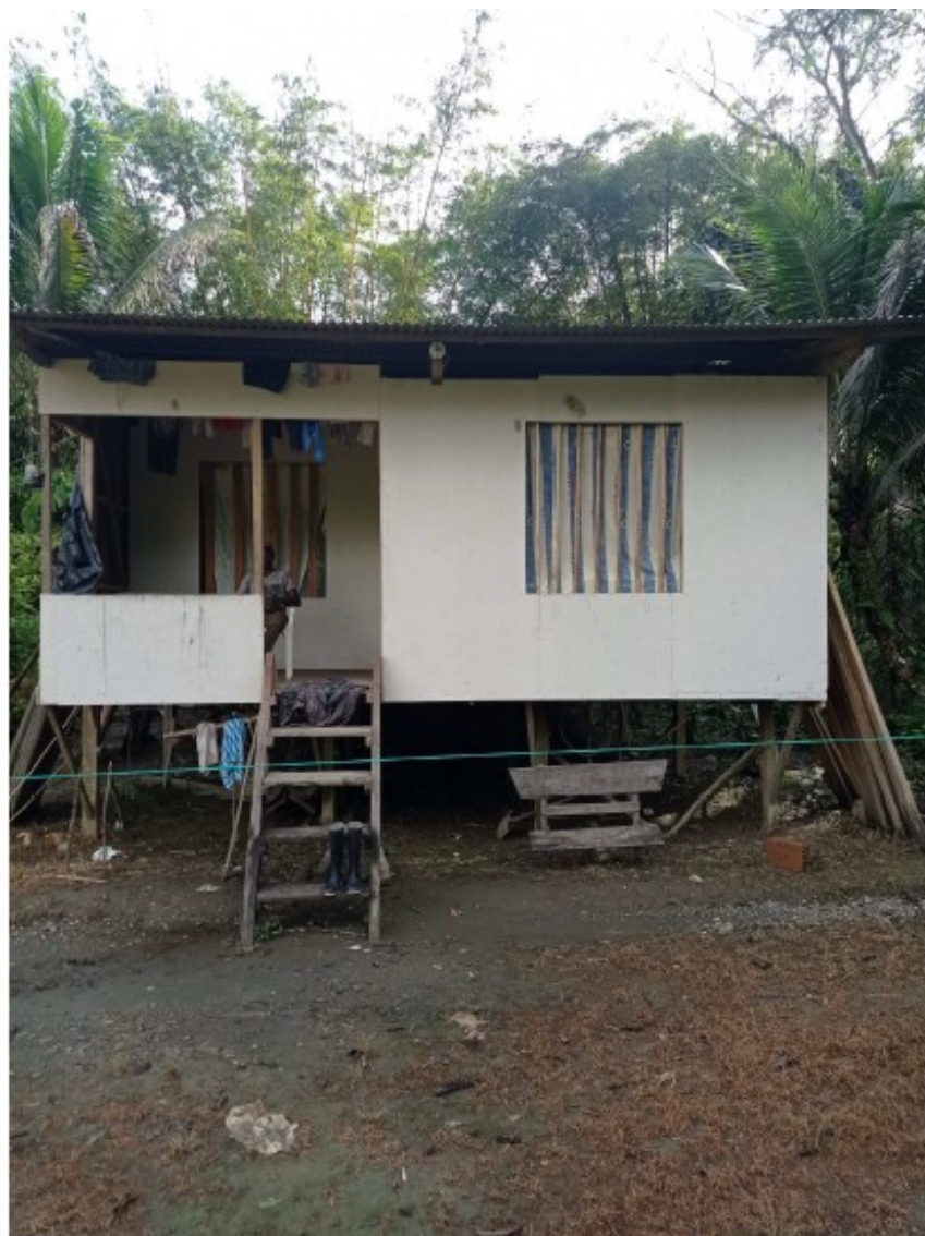
Ilustración 6. Registro fotográfico de la fachada del predio
