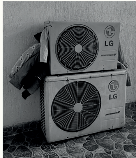
Figura 63. Condensadoras en proceso, Fotografía.
