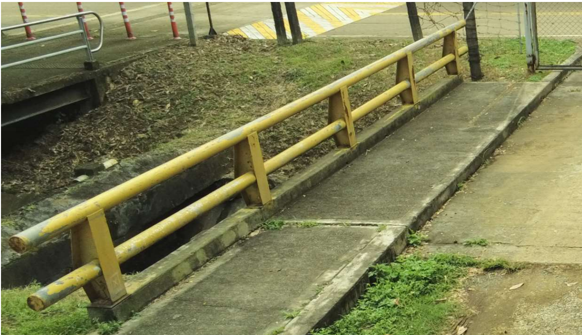
Fotografía No 10. Baranda, costado derecho
