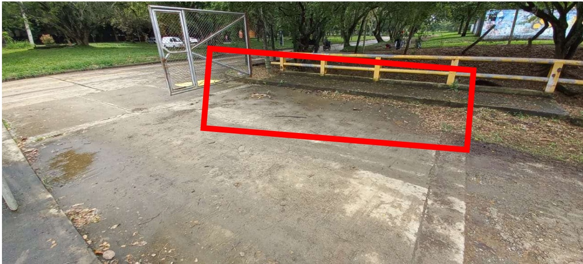
Fotografía No 3. Superficie del puente
