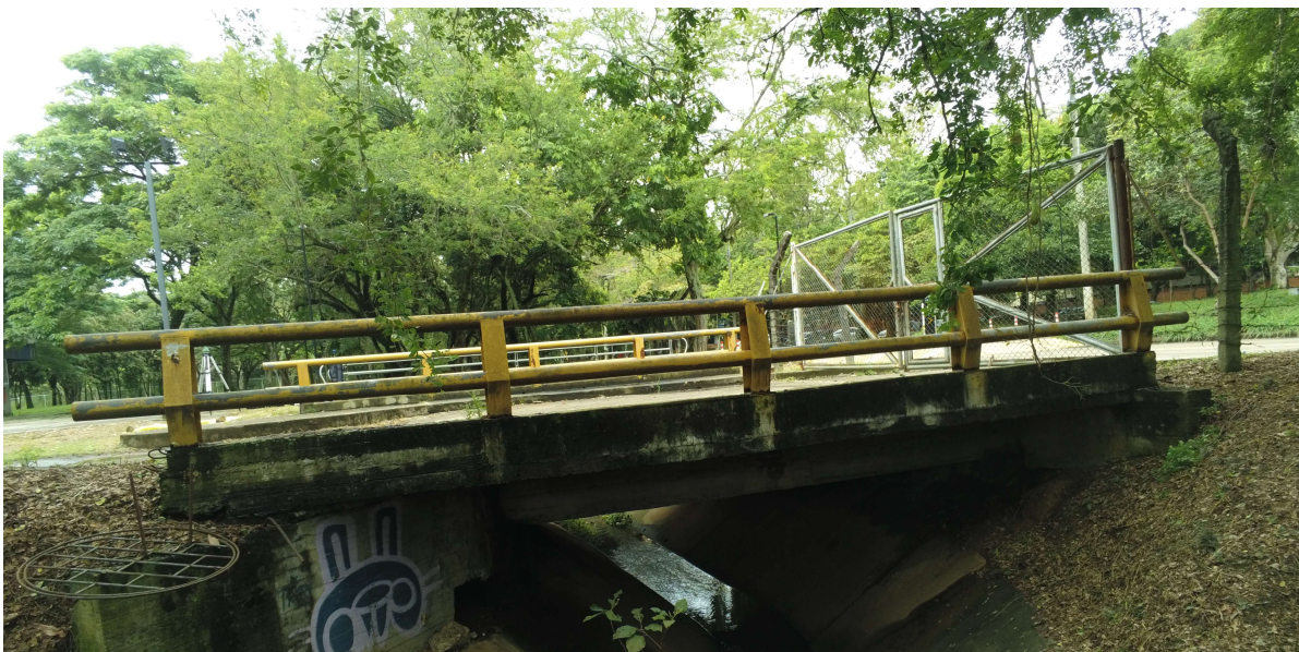
Fotografía No 7. Anden costado izquierdo
