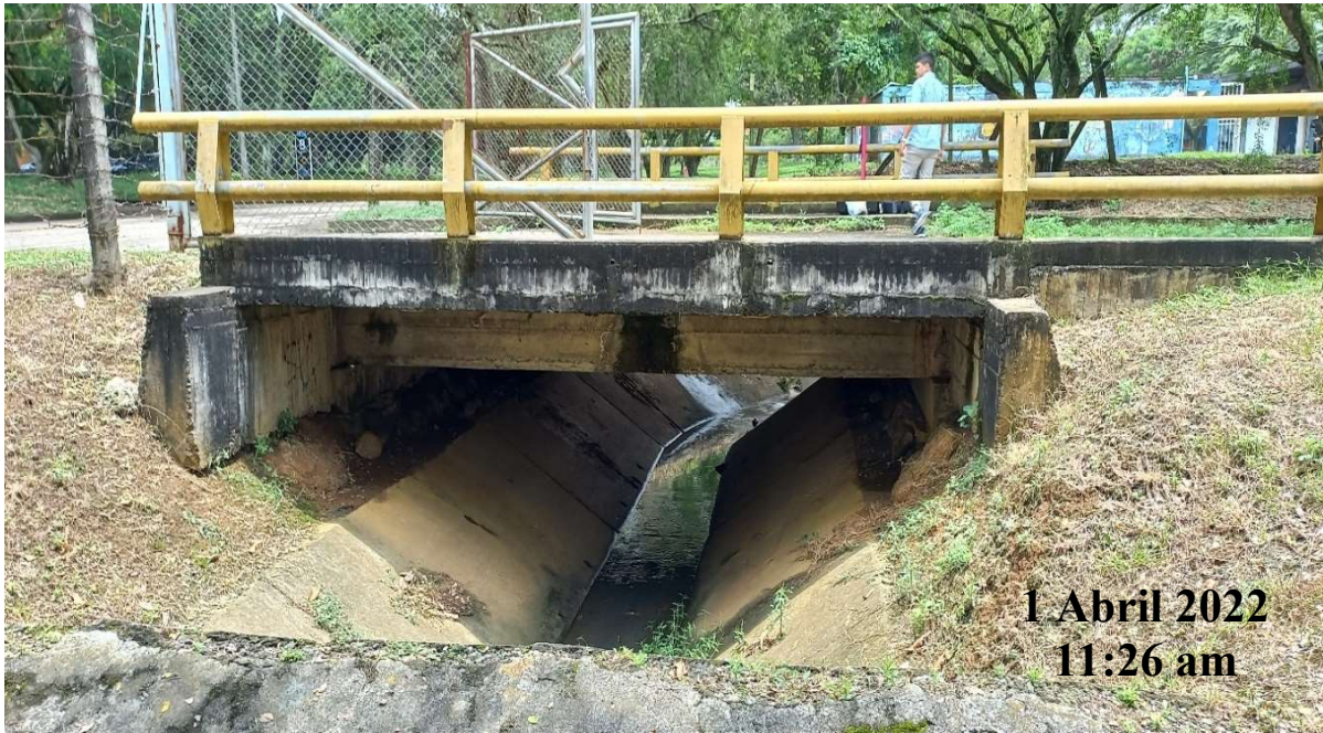
Fotografía No 2. Panorámica de la Estructura en Perfil
