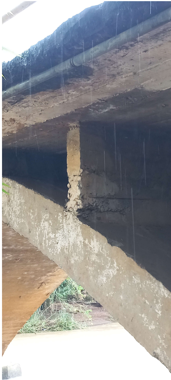
Fotografía No 32. Superestructura en concreto, Arcos en concreto, Muros. Aguas Arriba.
