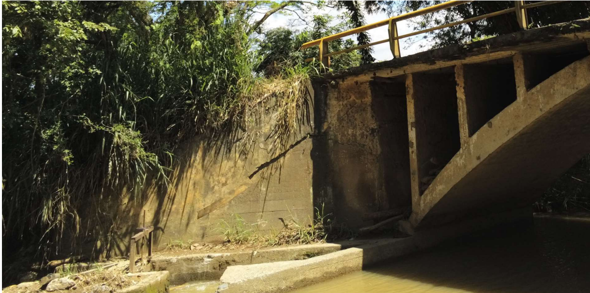
Fotografía No 14. Aleta Final Aguas Abajo, Cara frontal
