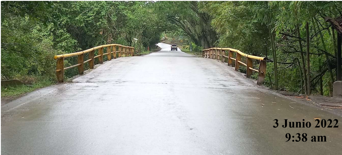
Fotografía No 1. Panorámica de la Estructura en Superficie
