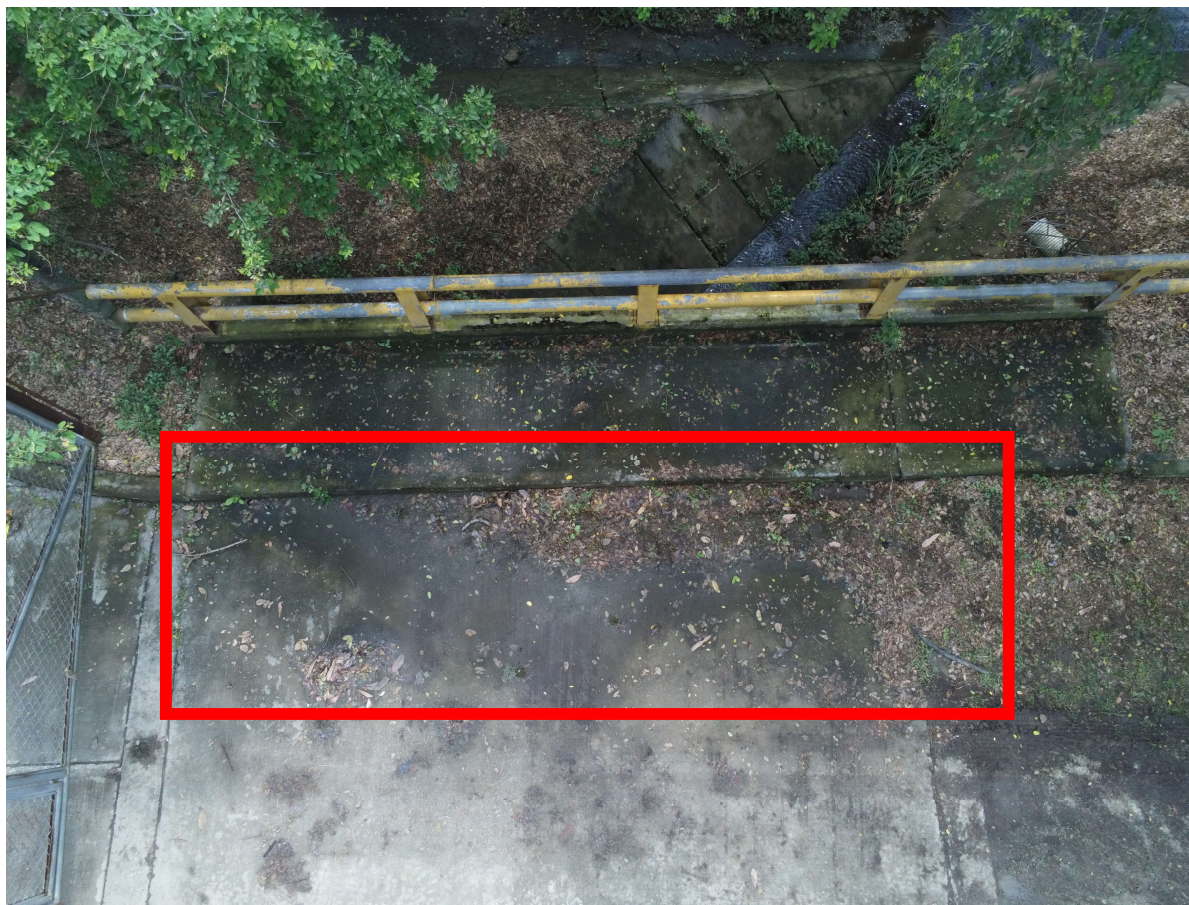
Fotografía No 3. Superficie del puente
