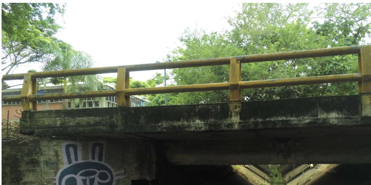
Fotografía No 7. Anden costado izquierdo
