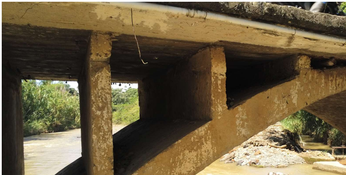
Fotografía No 30. Superestructura en concreto, Arcos en concreto, Muros. Aguas Arriba.
