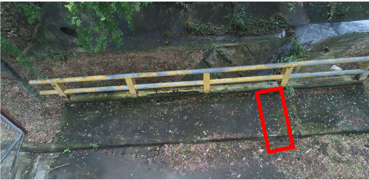
Fotografía No 5. Anden costado izquierdo
