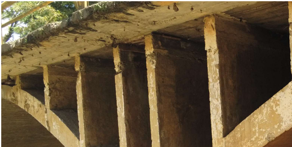
Fotografía No 27. Superestructura en concreto, Arcos en concreto, Muros. Aguas Abajo.
