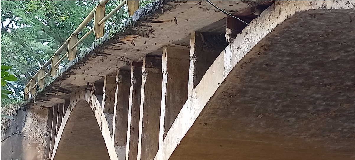
Fotografía No 30. Superestructura en concreto, Arcos en concreto, Muros. Aguas Abajo.
