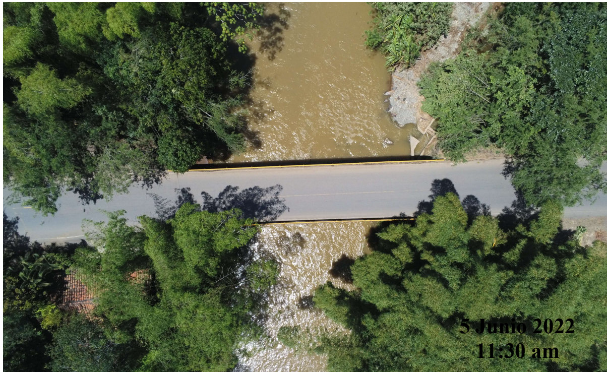
Fotografía No 1. Panorámica de la Estructura en Superficie
