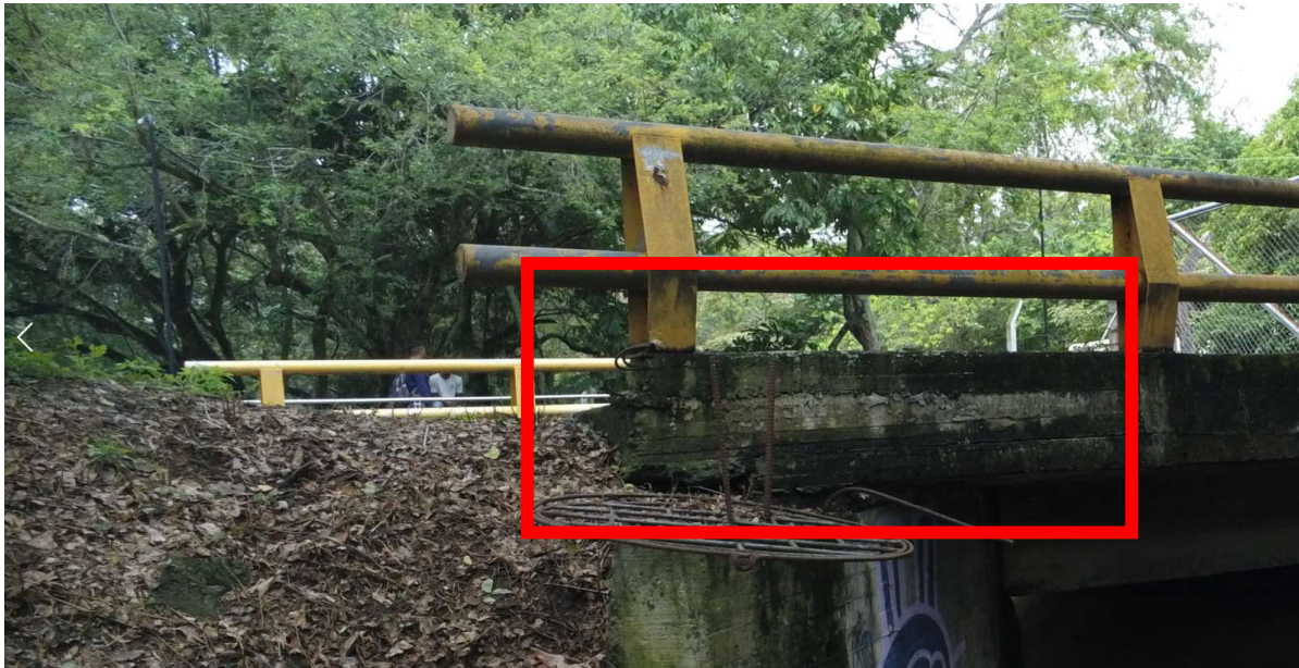
Fotografía No 8. Bordillo costado izquierdo
