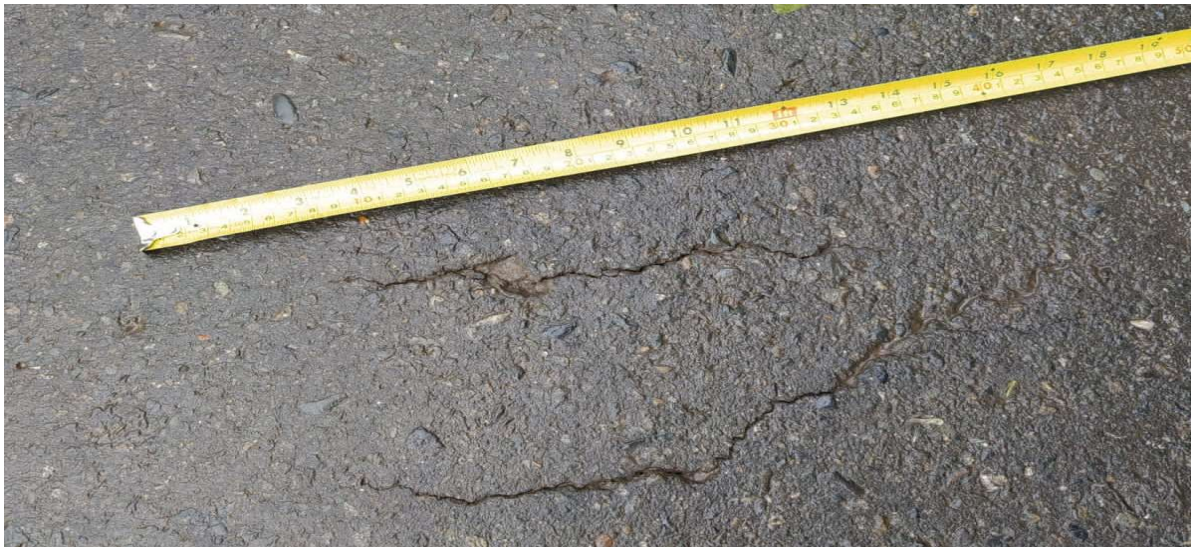
Fotografía No 4. Superficie del puente, carril derecho
