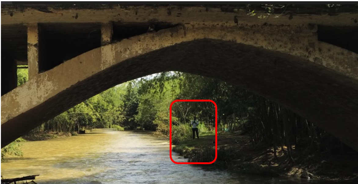
Figura 37 Ubicación del inspector durante la inspección visual empleando VANT. Costado derecho del puente.
