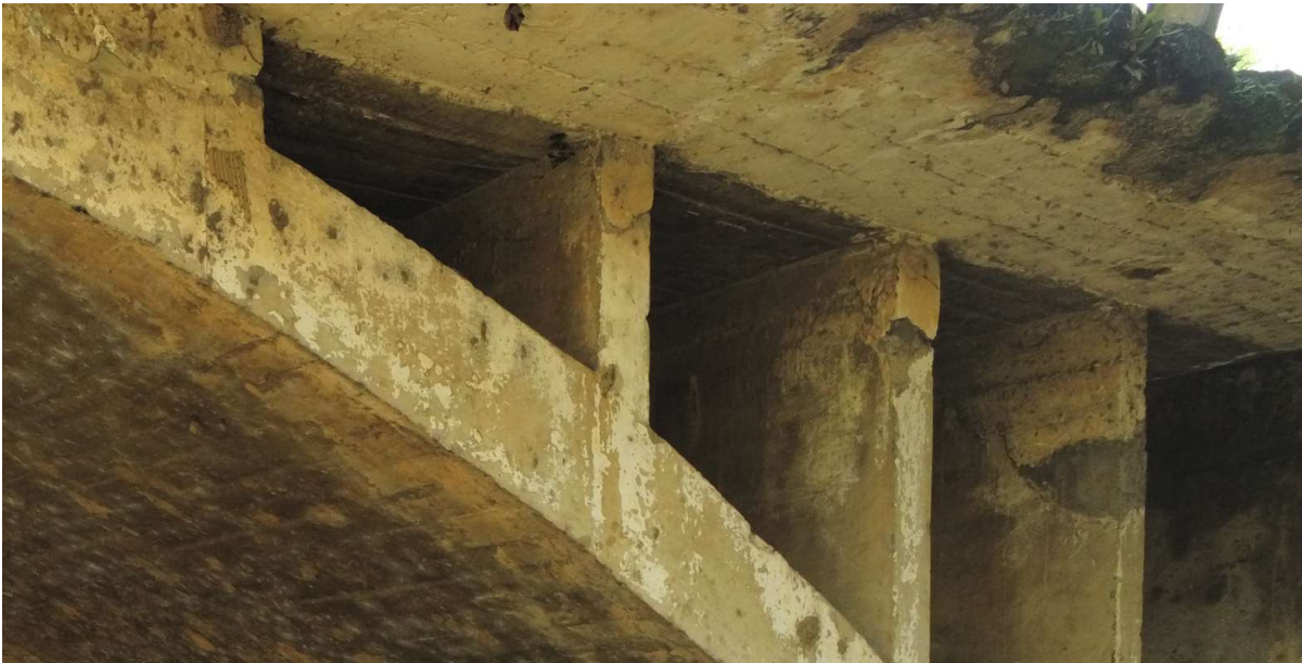
Fotografía No 26. Superestructura en concreto, Arcos en concreto, Muros. Aguas Abajo.
