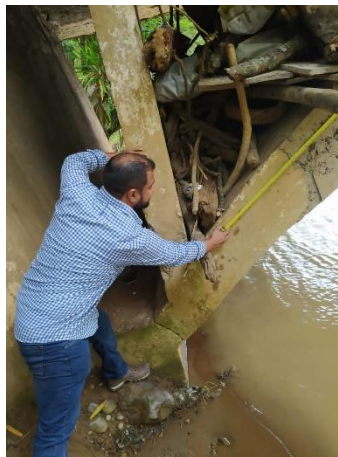
Figura 29 Exposición del inspector durante la inspección visual tradicional. Parte inferior del puente.
