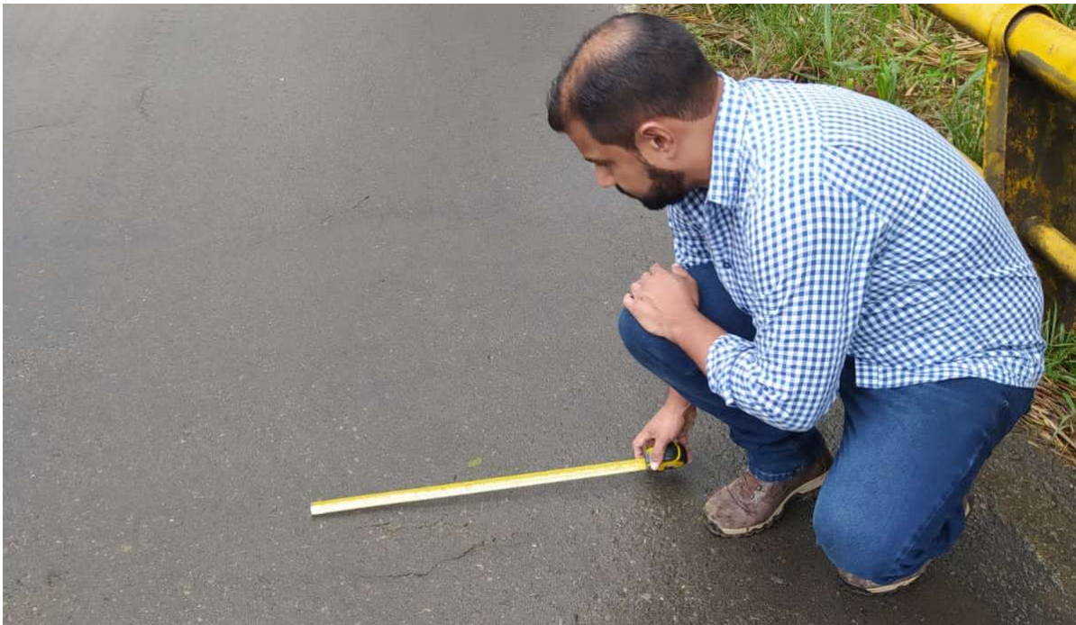
Fotografía No 3. Superficie del puente, carril derecho
