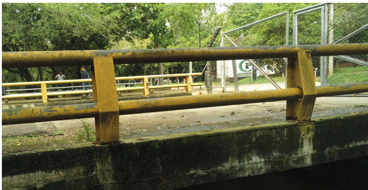
Fotografía No 12. Baranda, costado izquierdo
