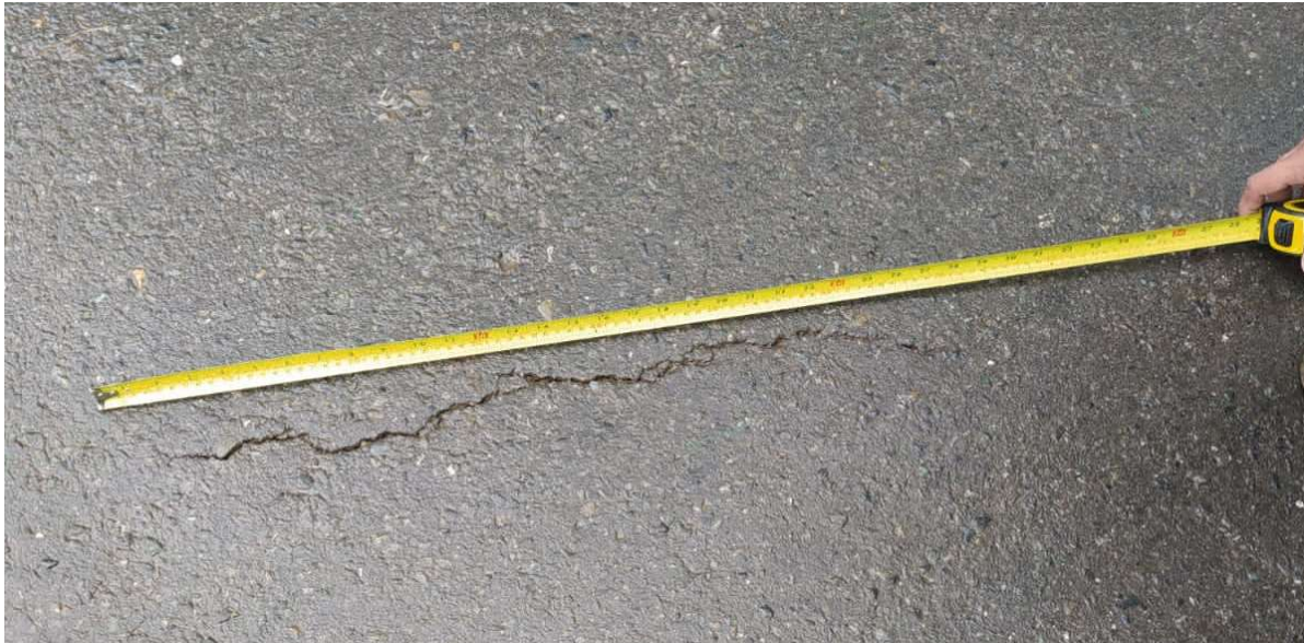
Fotografía No 5. Superficie del puente, carril izquierdo
