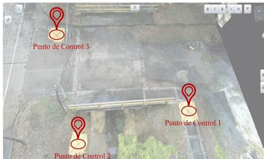
Figura 25 Localización puntos de control, Puente Piloto, Universidad del Valle
