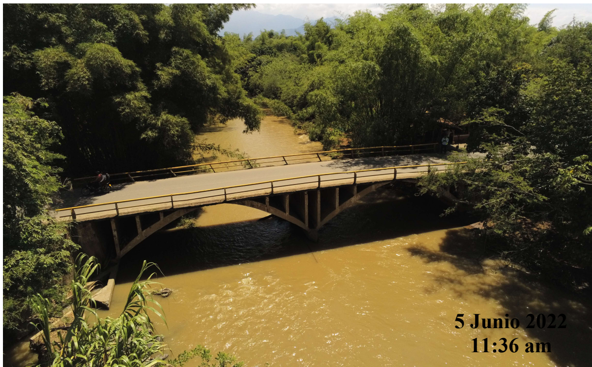
Fotografía No 2. Panorámica de la Estructura en Perfil. Aguas Abajo.
