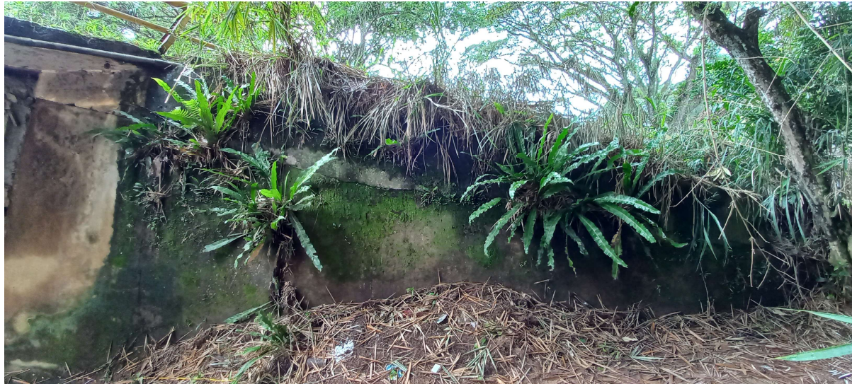
Fotografía No 17. Aleta Final Aguas Arriba, Cara frontal
