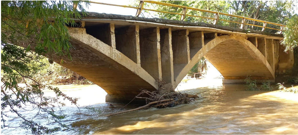
Figura 7 Puente Río Claro. Propio del Caso de Estudio
