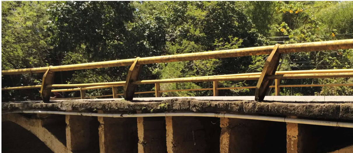
Fotografía No 9. Baranda metálica, Aguas Arriba.
