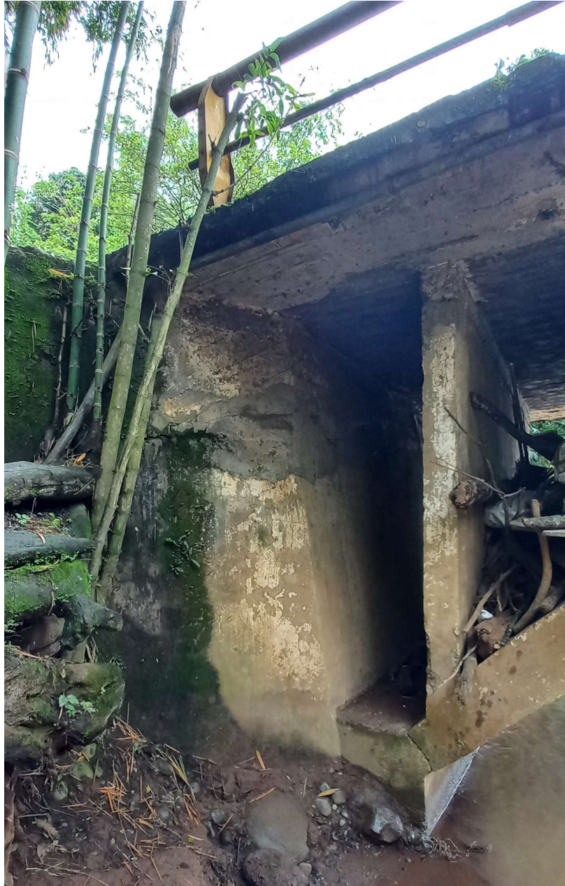
Fotografía No 15. Aleta Inicio Aguas Arriba, Cara frontal
