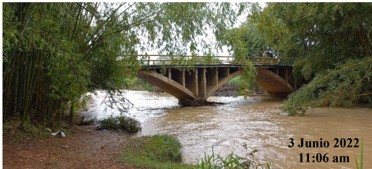
Fotografía No 2. Panorámica de la Estructura en Perfil, Aguas Arriba
