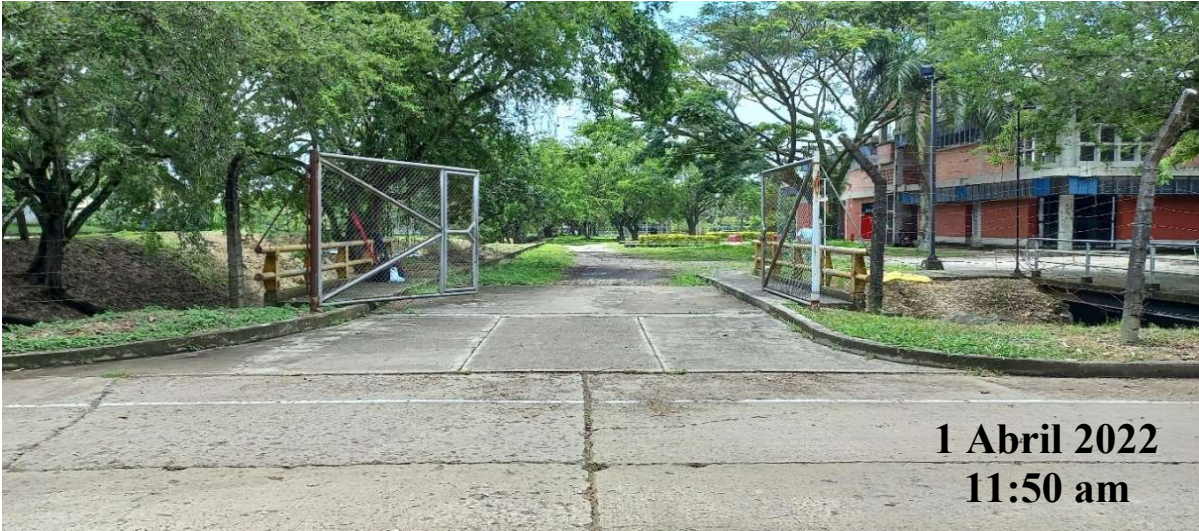
Fotografía No 1. Panorámica de la Estructura en Superficie
