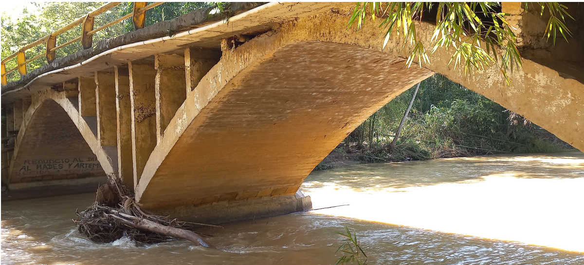
Fotografía No 33. Superestructura en concreto, Arcos en concreto, Losa. Aguas Arriba.
