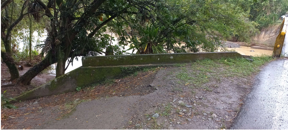
Fotografía No 13. Aleta Inicio Aguas Abajo, Cara posterior
