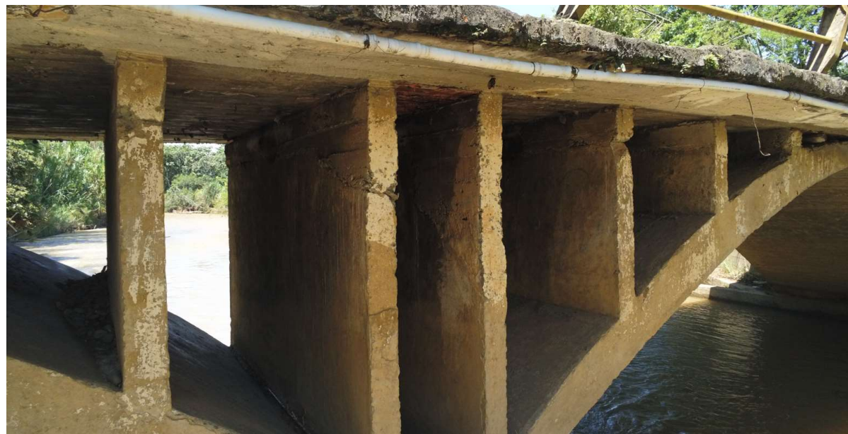
Fotografía No 31. Superestructura en concreto, Arcos en concreto, Muros. Aguas Arriba.
