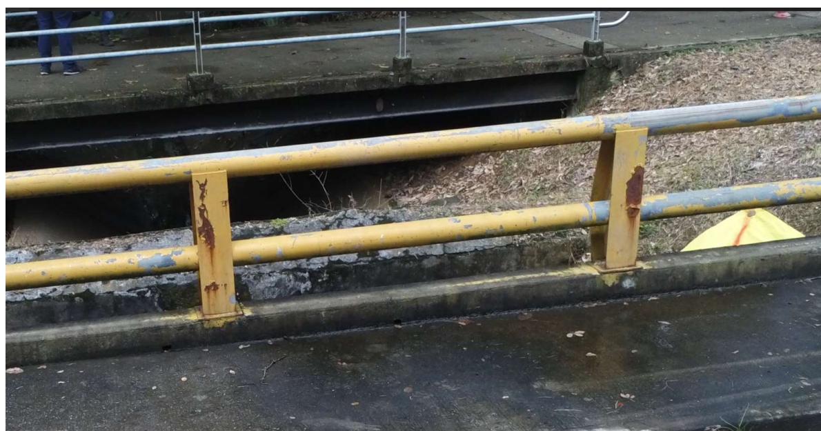
Fotografía No 10. Baranda, costado derecho
