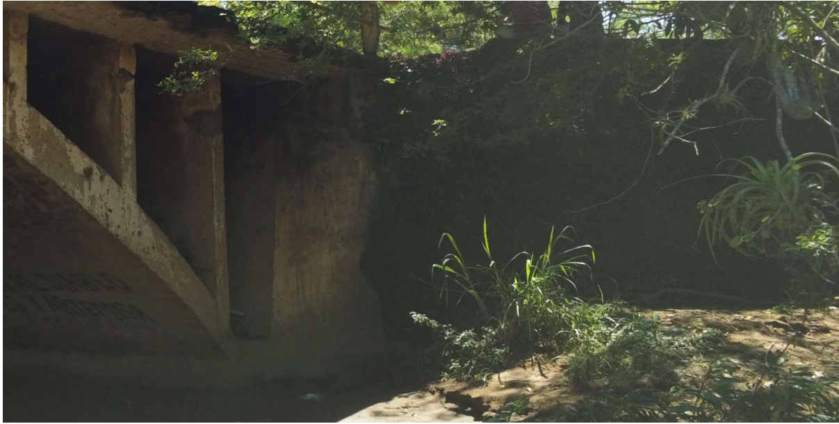
Fotografía No 12. Aleta Inicio Aguas Abajo, Cara frontal
