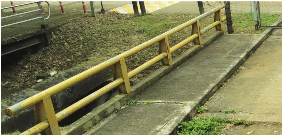
Fotografía No 4. Anden costado derecho
