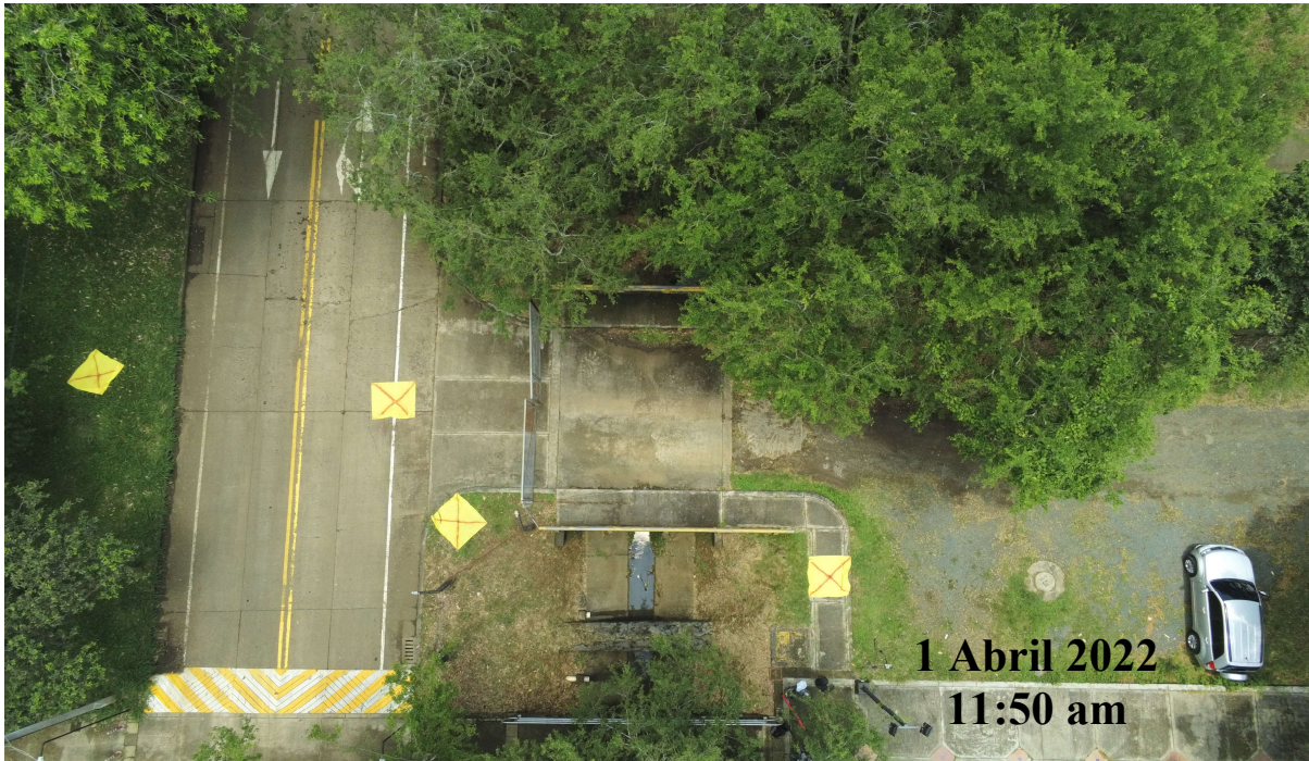
Fotografía No 1. Panorámica de la Estructura en Superficie
