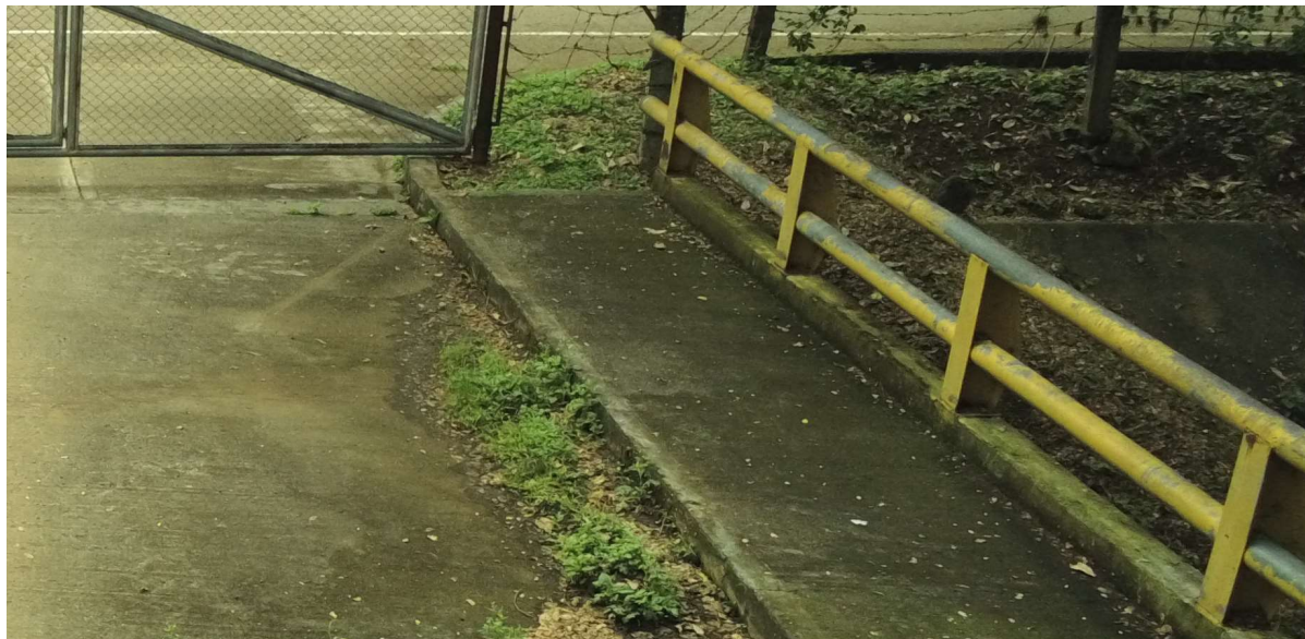
Fotografía No 12. Baranda, costado izquierdo
