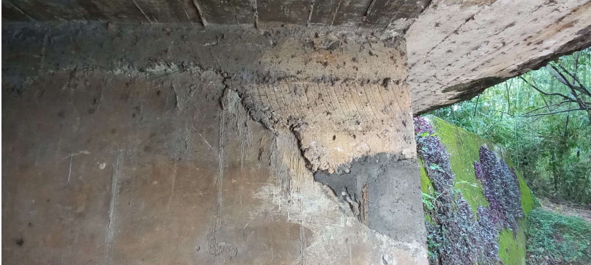
Fotografía No 28. Superestructura en concreto, Arcos en concreto, Muros. Aguas Abajo.
