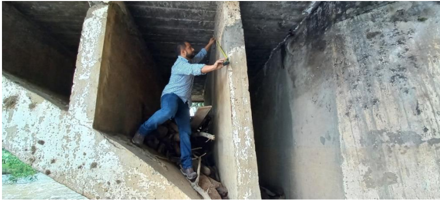
Figura 43 Exposición del inspector durante la cuantificación de daños, inspección visual tradicional. Parte inferior del puente.
