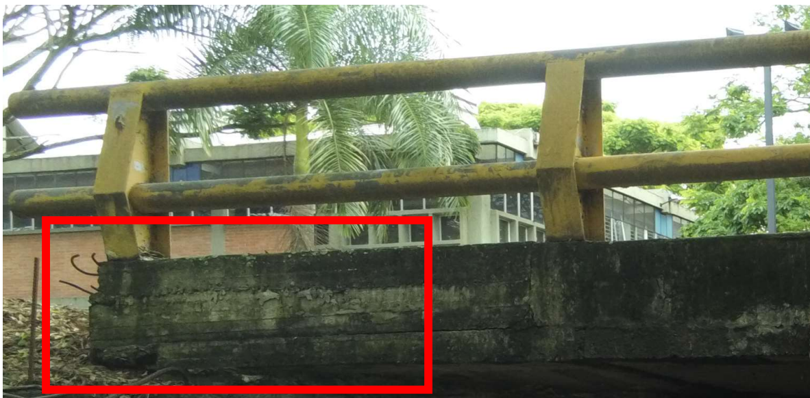
Fotografía No 8. Bordillo costado izquierdo
