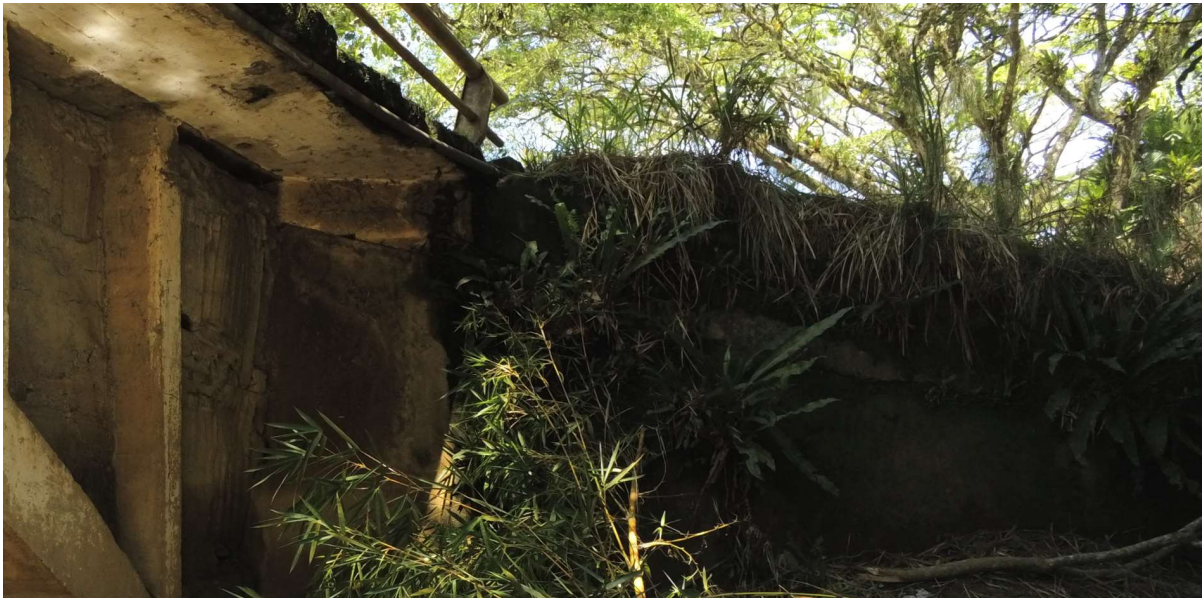
Fotografía No 15. Aleta Final Aguas Arriba, Cara frontal
