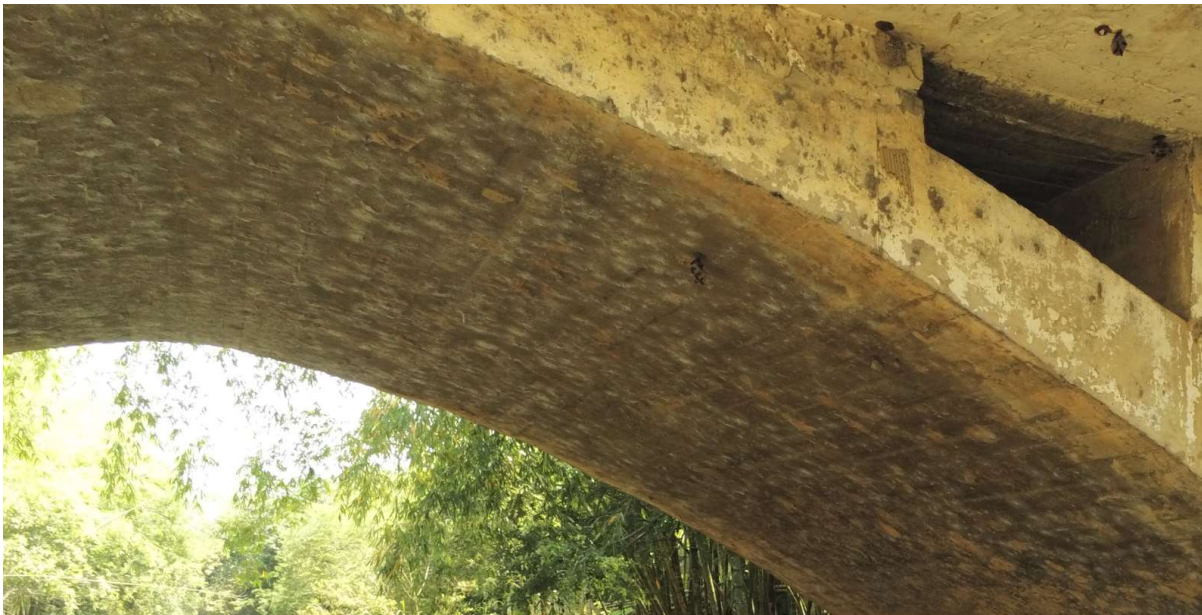
Fotografía No 33. Superestructura en concreto, Arcos en concreto, Losa.
