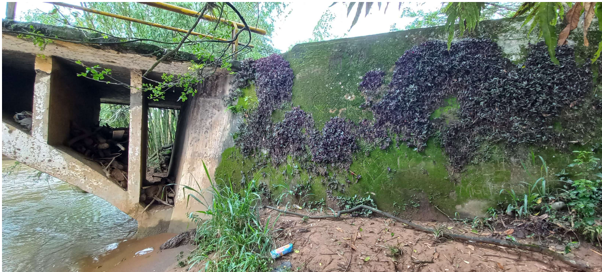
Fotografía No 14. Aleta Inicio Aguas Abajo, Cara frontal
