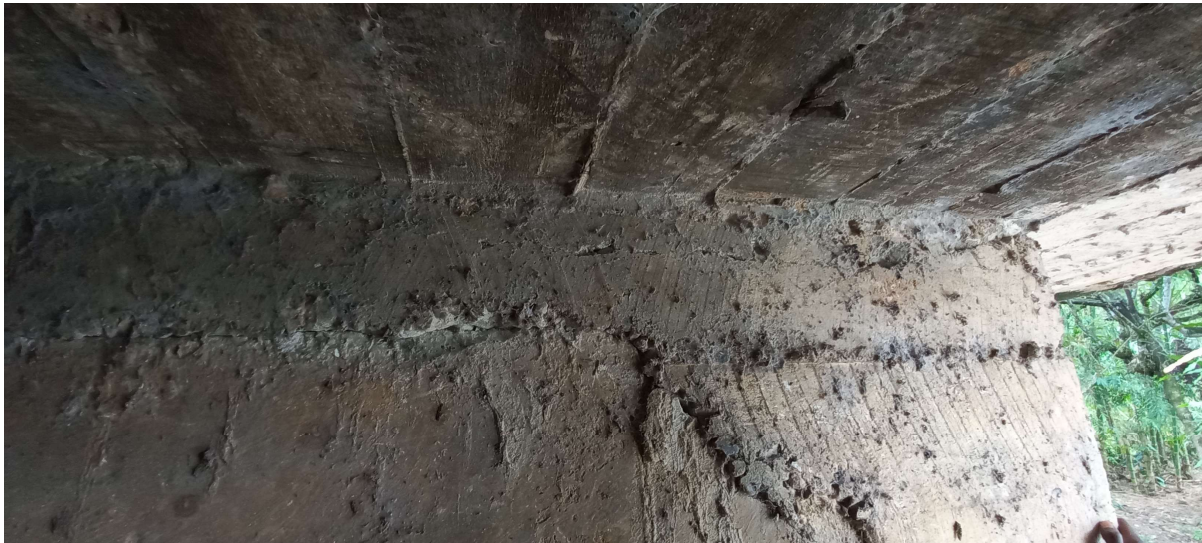
Fotografía No 29. Superestructura en concreto, Arcos en concreto, Muros. Aguas Abajo.
