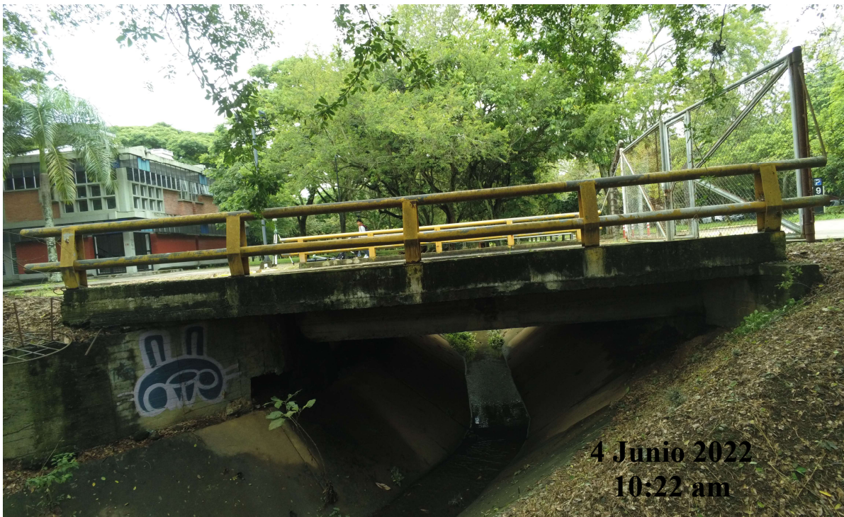
Fotografía No 2. Panorámica de la Estructura en Perfil
