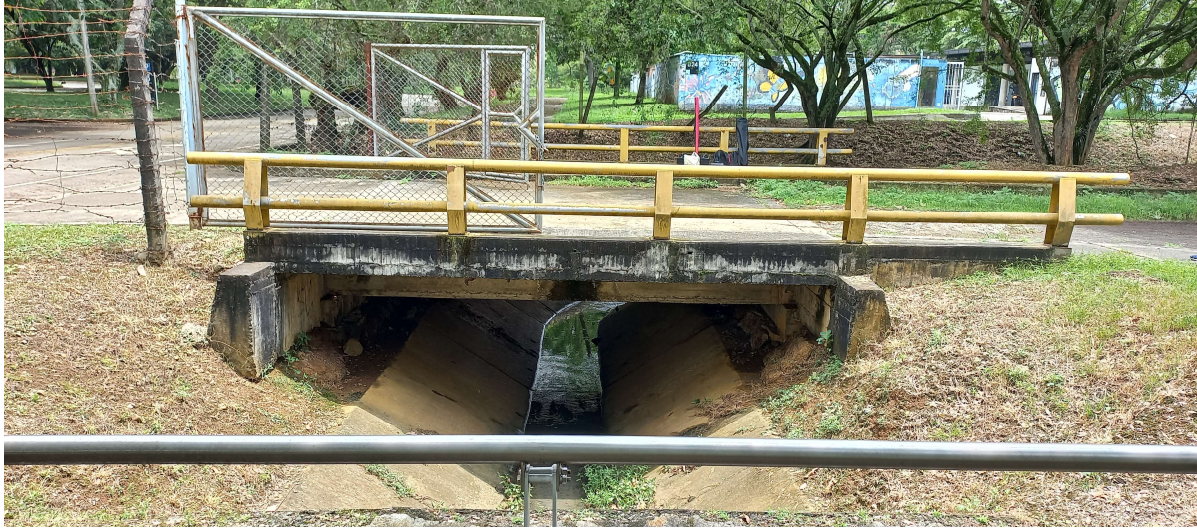
Fotografía No 11. Barandas metálicas
