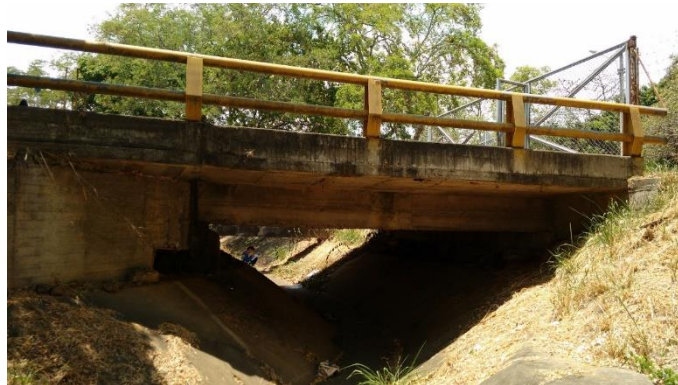
Figura 17 Puente Piloto, (Geovisor IDESC)
