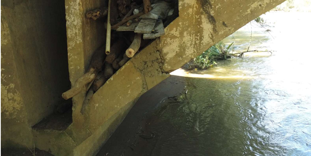
Fotografía No 32. Superestructura en concreto, Arcos en concreto, Losa. Aguas Arriba.
