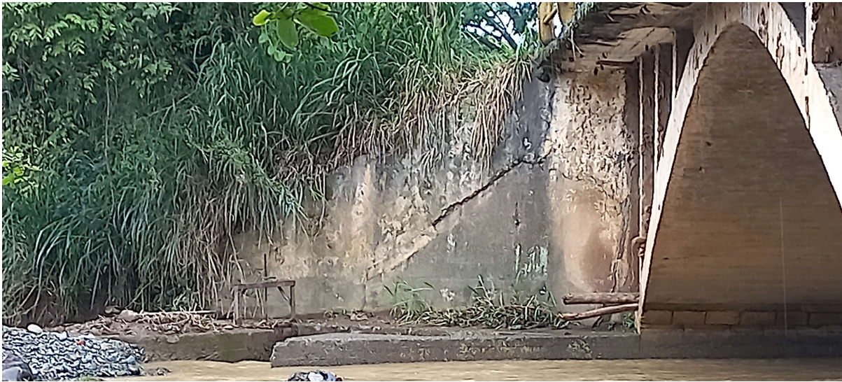
Fotografía No 16. Aleta Final Aguas Abajo, Cara frontal
