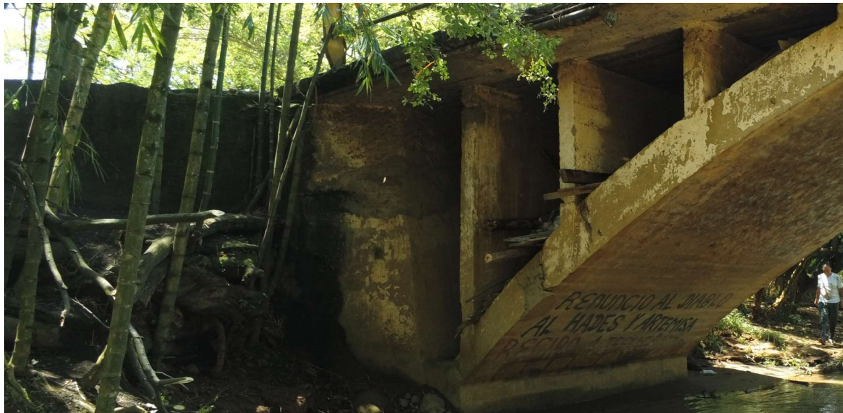
Fotografía No 13. Aleta Inicio Aguas Arriba, Cara frontal
