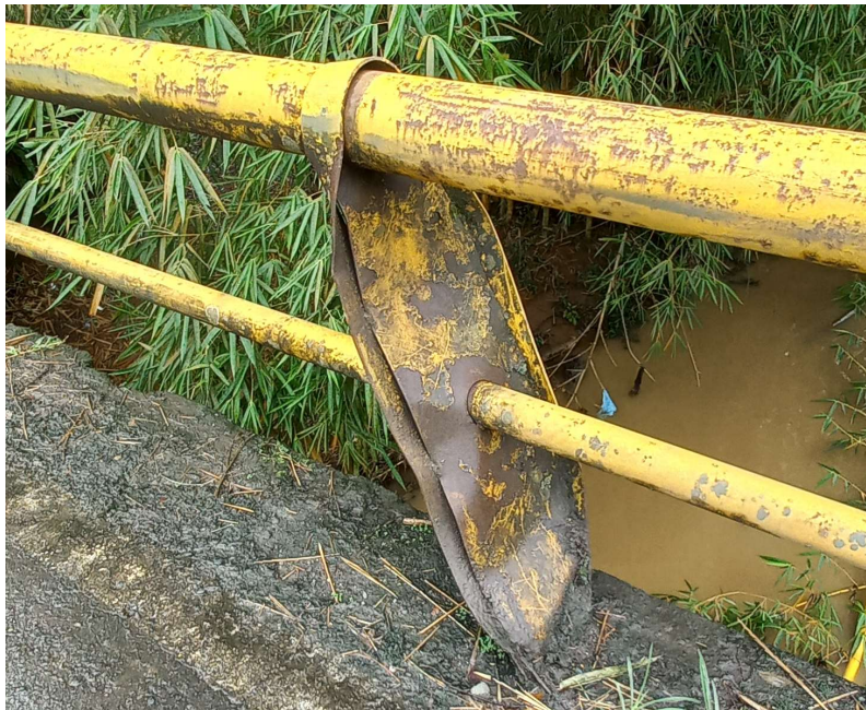
Fotografía No 10. Baranda metálica, Aguas Arriba
