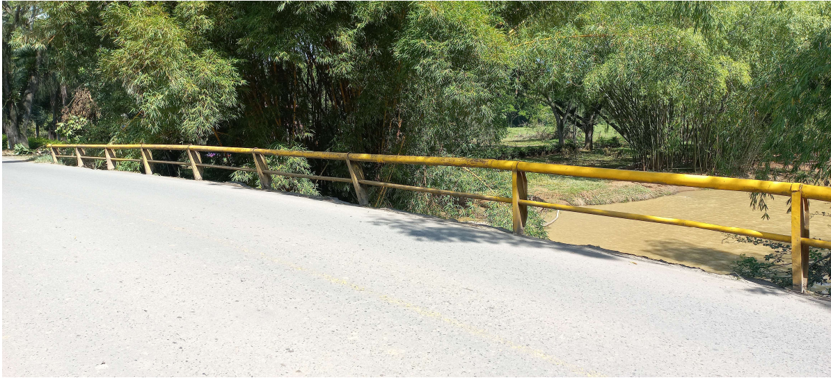
Fotografía No 9. Baranda metálica, Aguas Arriba
