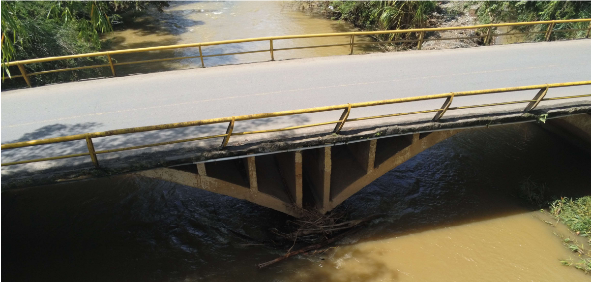
Fotografía No 8. Baranda metálica, Aguas Arriba.
