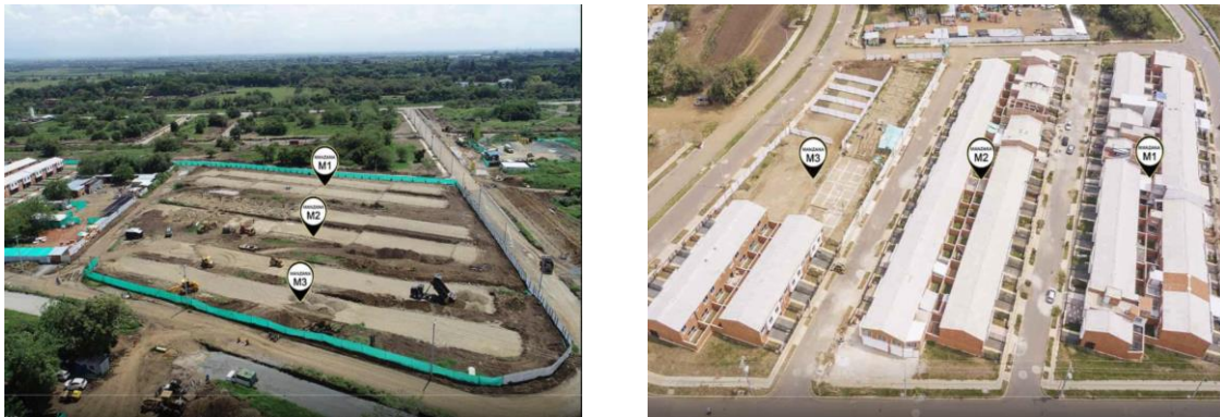
Figura 21. Vista aérea del proyecto a agosto 2018. Fuente: Constructora Bolívar.
