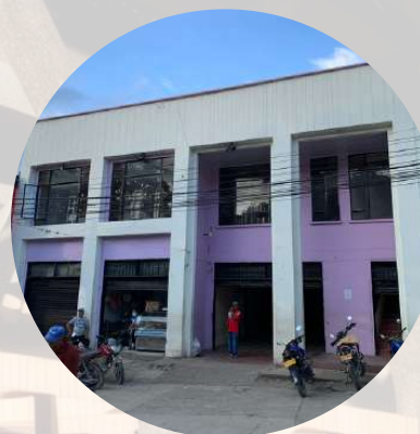
ACCESO PRINCIPAL PLAZA DE MERCADO ACTUAL
