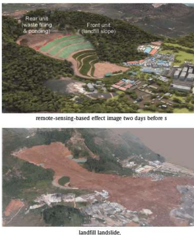
Figura 17. Vistas tomadas con vehículos aéreos no tripulados en el deslizamiento de Shenzhen China (Yin et al., 2016).
