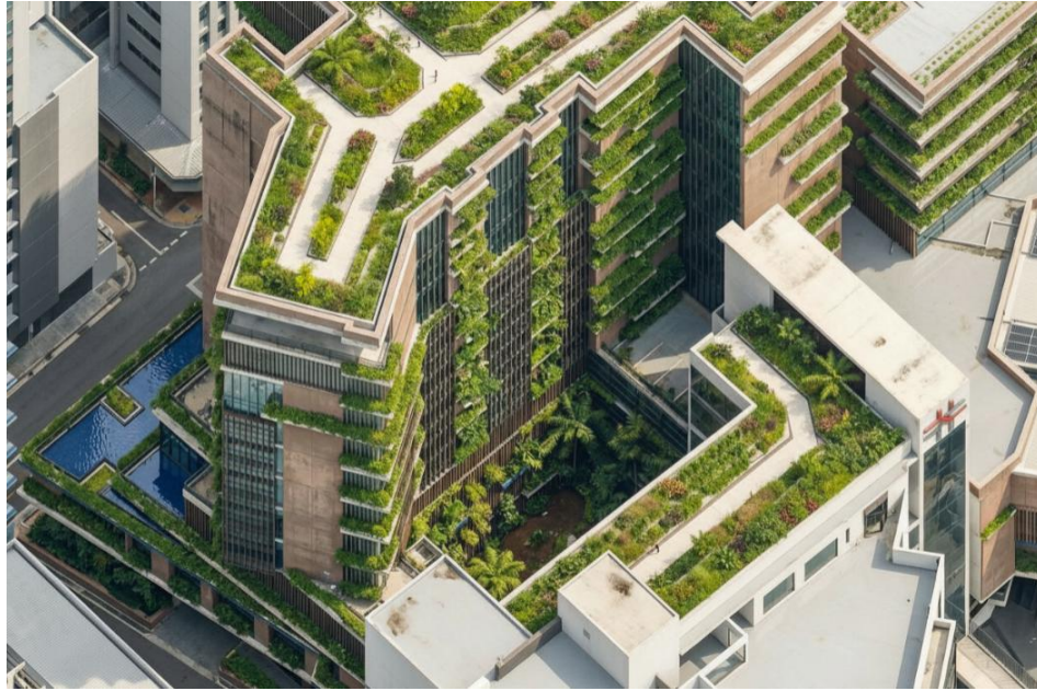
Visual aérea costado norte, jardín interno.
