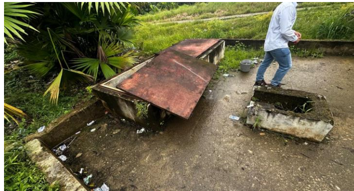
Figura 19 Cuarto de Bombas y Tanque de almacenamiento
