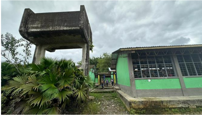
Figura 10 Colegio y tanque elevado actual
