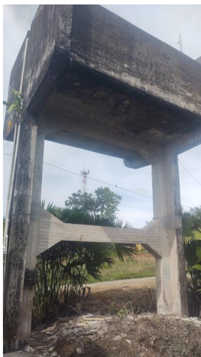
Figura 21 Tanque elevado de concreto
