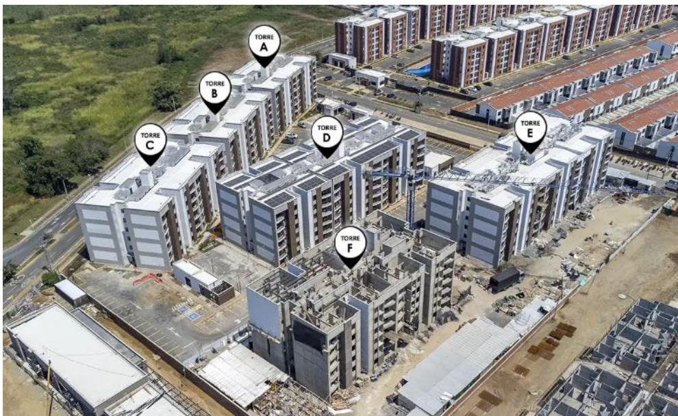
Figura 11 Avance de obra. Enero 2024 (Constructora Bolívar, 2024).
