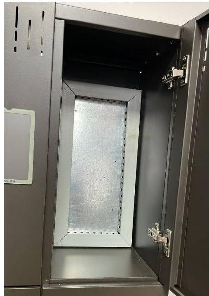
Figura 6.13: Ubicación del tablero eléctrico.
