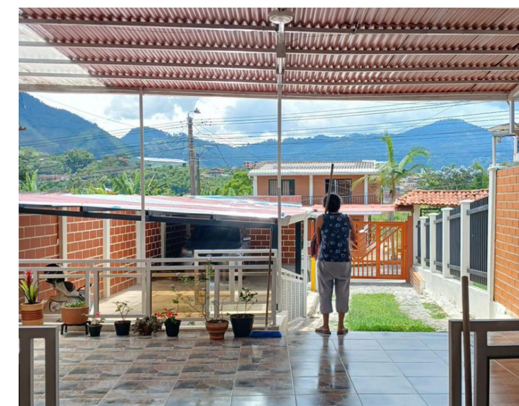
Imagen 19 Casa de estudio mampostería 12 Fuente propia
