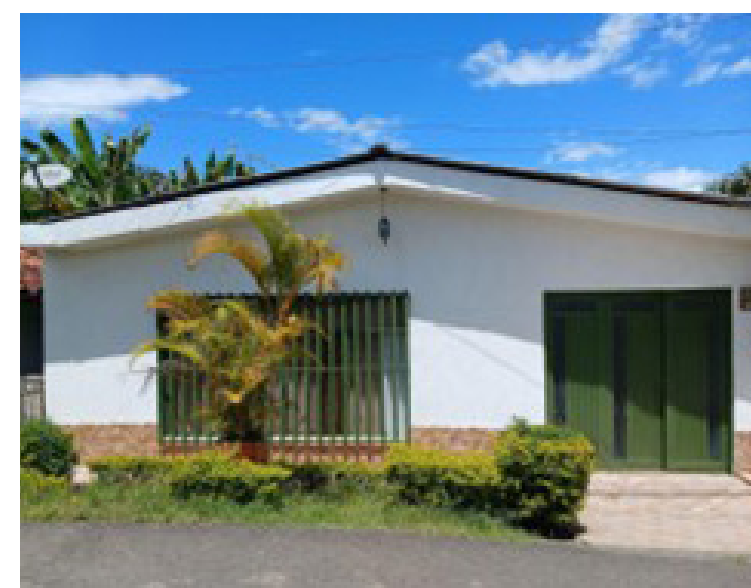
Imagen 16 Casa de estudio mampostería 09 Fuente propia
