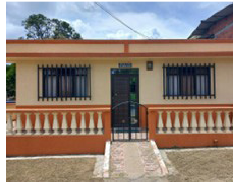
Imagen 14 Casa de estudio mampostería 07 Fuente propia
