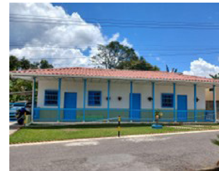
Imagen 15 Casa de estudio mampostería 08 Fuente propia
