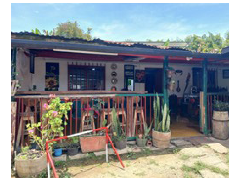
Imagen 18 Casa de estudio mampostería 11 Fuente propia
