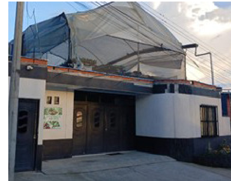
Imagen 17 Casa de estudio mampostería 10 Fuente propia
