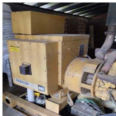
Figura 8. Estado de la casa de máquinas.
