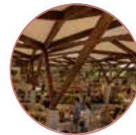
Estructura en acero, oxidación natural
