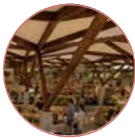
Estructura en acero, oxidación natural
