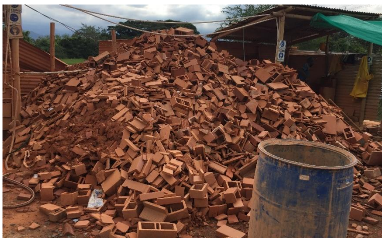
Figura 20. RCD generado en zona de cortadoras
