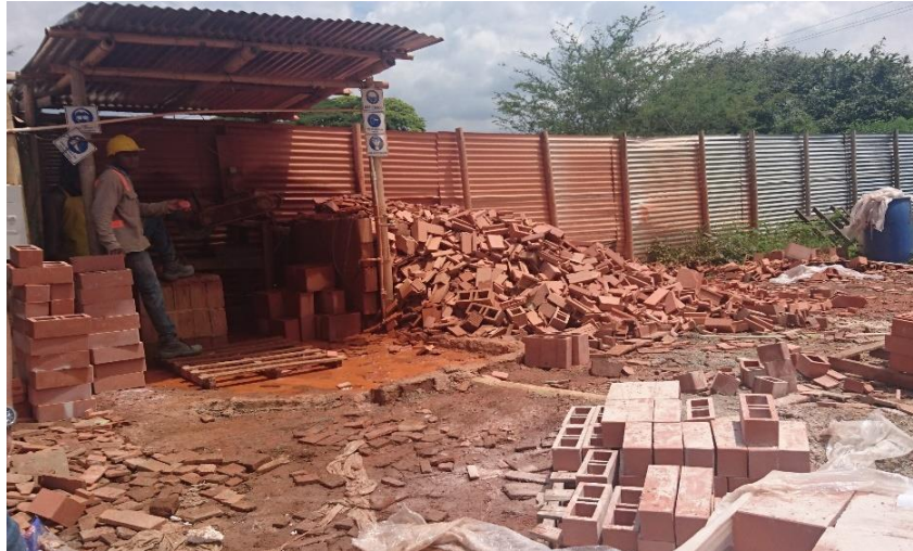
Figura 17. Zona de corte de ladrillo y acopio de residuos generados.
