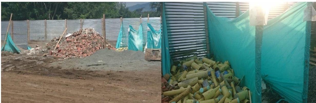
Figura 16. Acopios finales de RCD en el campamento.
