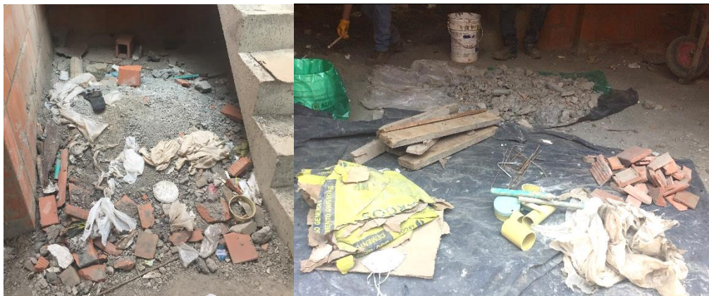
Figura 47. Ejemplo de la separación de los RCD en sus componentes para el aprovechamiento
