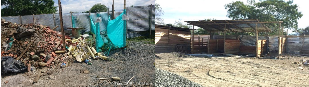
Figura 49. Acopios estacionarios en proyectos anteriores vs propuesta de cajones estacionarios.
