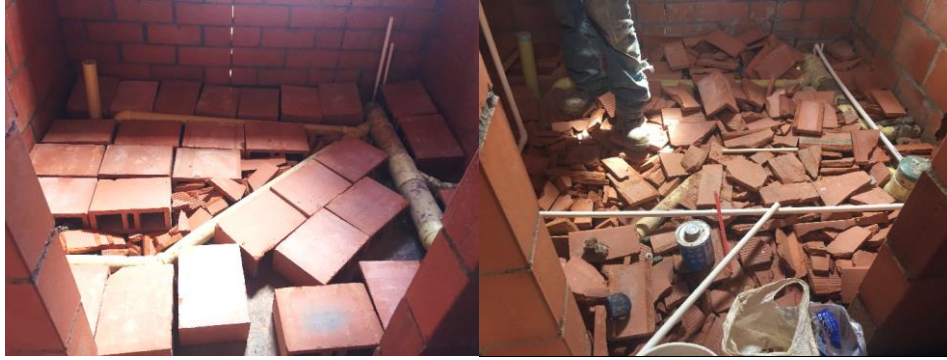
Figura 52. Uso de RCD como material de relleno en elemento no estructural.
