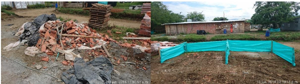
Figura 48. Acopio temporal en proyectos vs propuesta de acopio temporal para la separación del RCD
