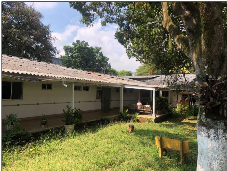
Imagen 1 - Estado Actual frente de intervención zona hospitalización san miguel
