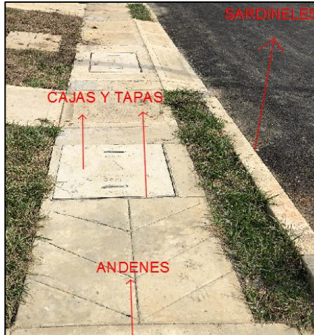
Figura 9. Identificación de elementos no estructurales. Fuente: Propia.
