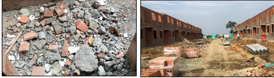
Figura 8. Generación residuos en sitio Fuente: Propia.
