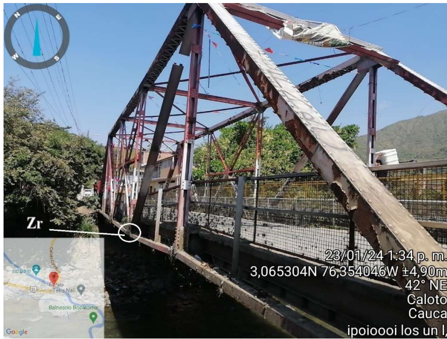
PUENTE EL PALO [Fotografía], INGENIERÍA DAPA. SAS, 2024.
