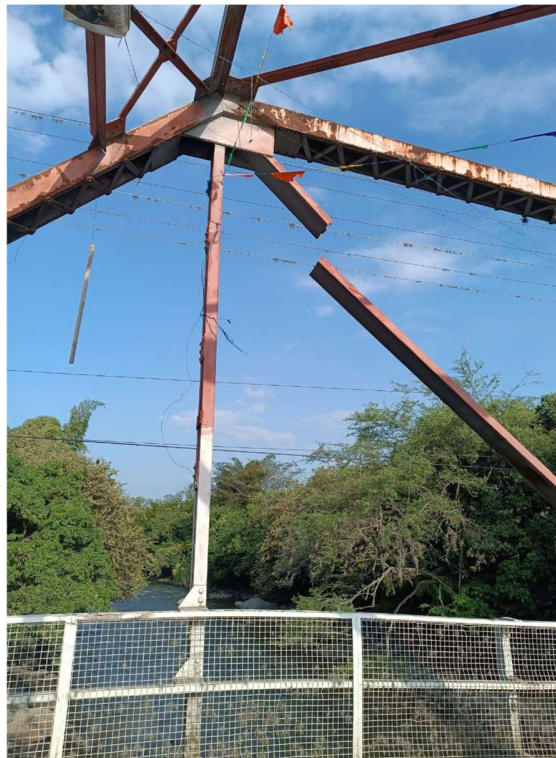
PUENTE EL PALO [Fotografía], INGENIERÍA DAPA. SAS, 2024.
