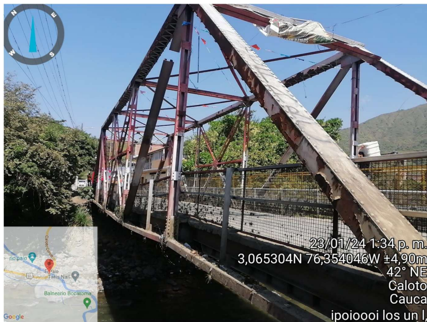
PUENTE EL PALO [FOTOGRAFÍA], INGENIERÍA DAPA. SAS, 2024
