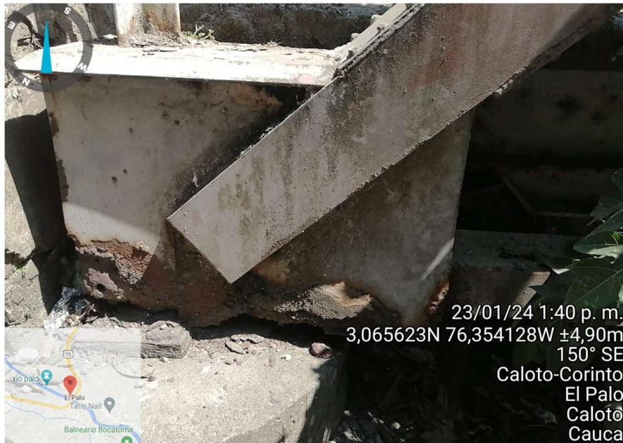
PUENTE EL PALO [Fotografía], INGENIERÍA DAPA. SAS, 2024.
