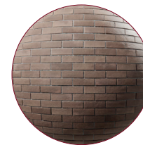
Ladrillo a la vista
