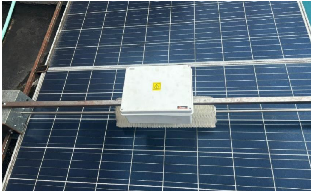
Figura 38. Robot encendido sobre la estructura
