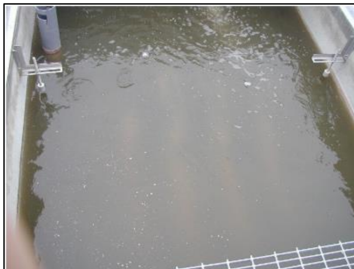
Ilustración 32. Sifón sumergido [15]
