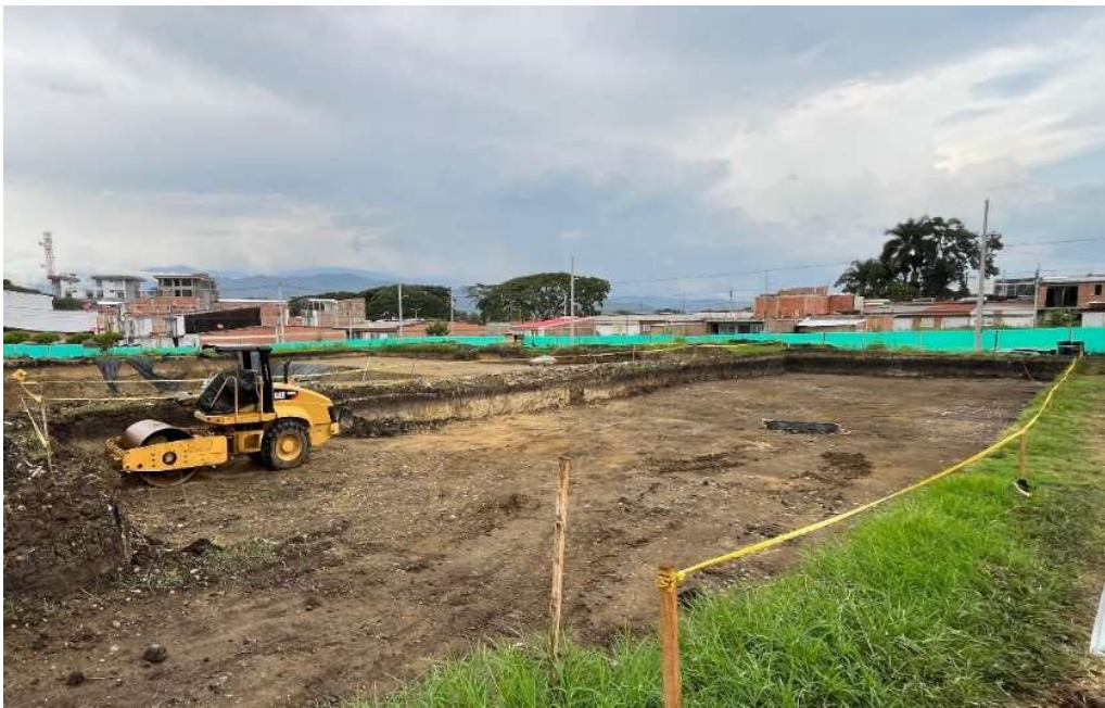
Imagen 6.2 Ejecución terraza proyecto piloto en la ciudad de Buga
