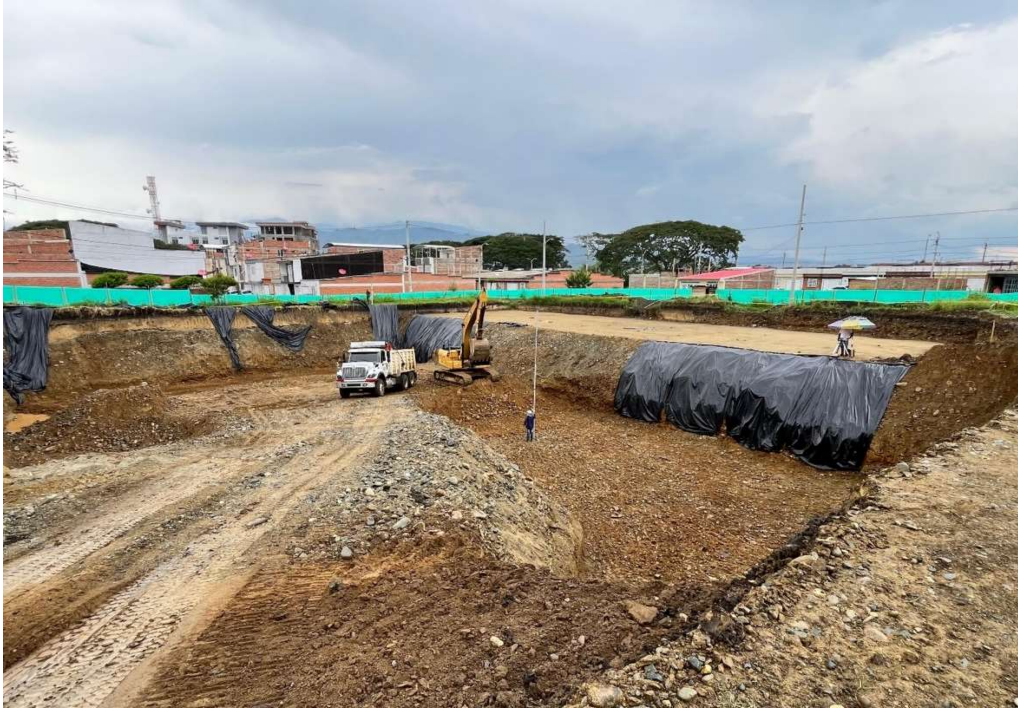
Imagen 6.1 Ejecución sótano proyecto piloto en la ciudad de Buga
