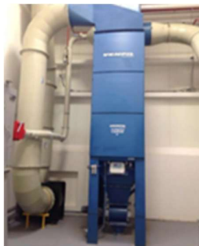
Fig. 4 Colectores de cartuchos de alta tecnología [5]
